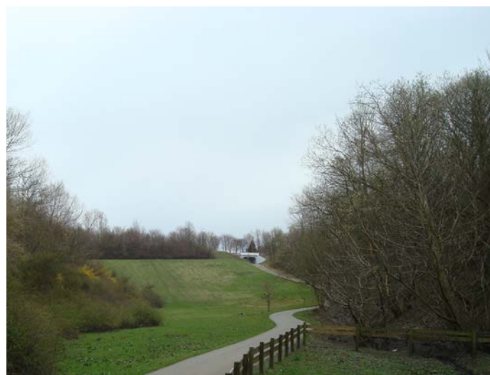
Gropen i norr med översvämningsmagasin (foto: Katinka Lovén)
