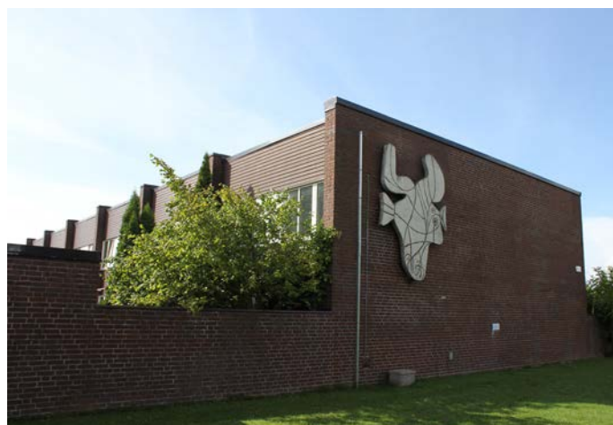
Befintliga radhus med en traditionell fasad av Helsingborgstegel och Picassos betongfisk (foto: Katinka Lovén)
