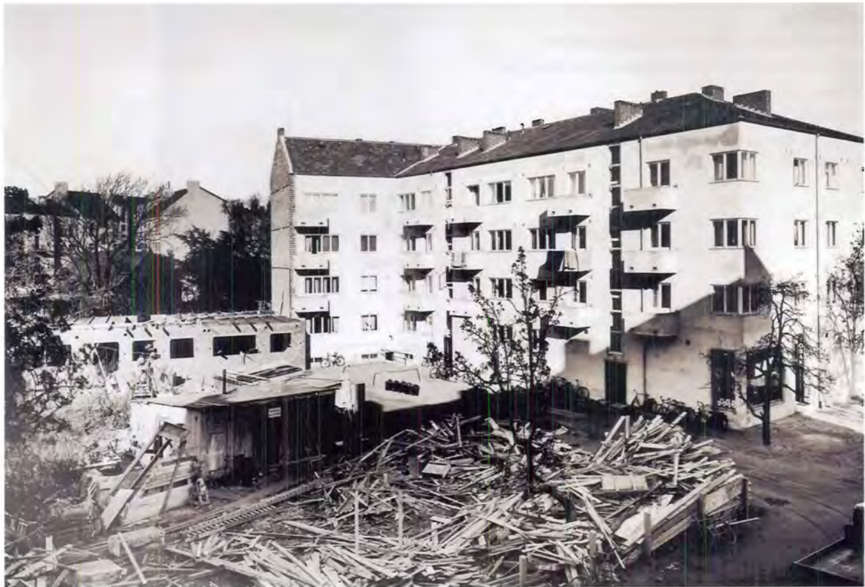
Fastigheten Eneborg 7, i korsningen av Övre Eneborgsvägen – Bjäregatan och Övre Holländaregatan. Eneborg 11 mot Övre Eneborgsvägen är under uppförande. Foto 1936.
