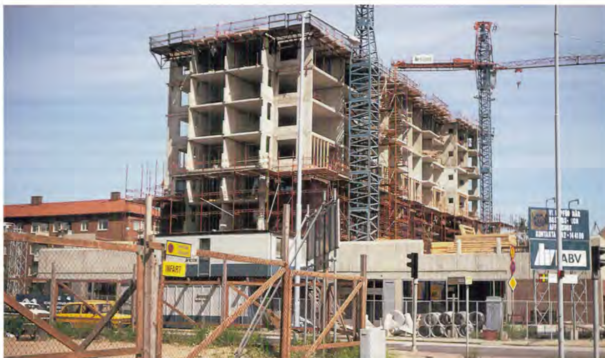
Pågående bygge i kvarteret Ostronet. Foto Edvin Hansson 1980.
