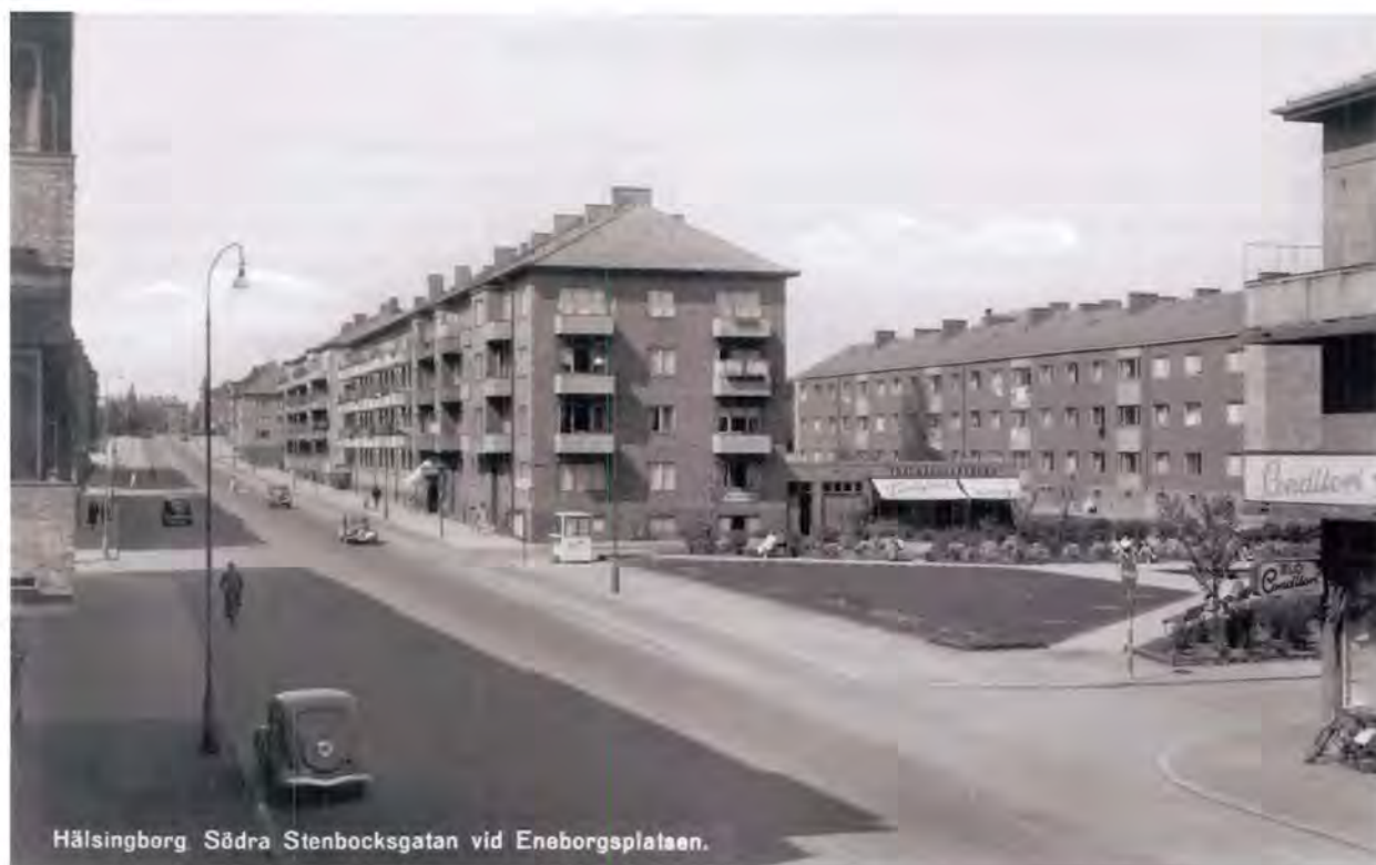
Eneborgsplatsen mot Stenbocksgatan.
