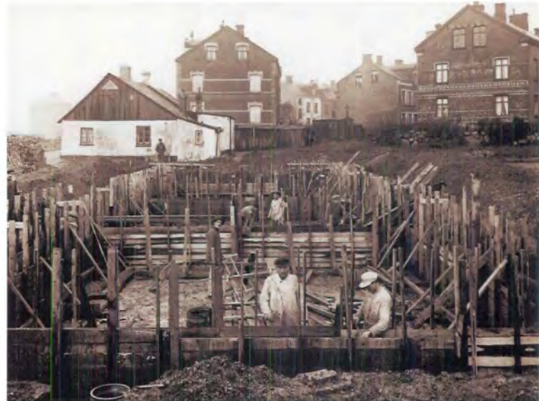
Byggnadsarbete 1916 vid Fältarpstegen. Det är huset Hummern 11, i hörnet av Fältarpstegen och Varbergsgatan som är under uppförande. Husen bakom är nu rivna. I bakgrunden skimtar Gustav Adolfs skola.
