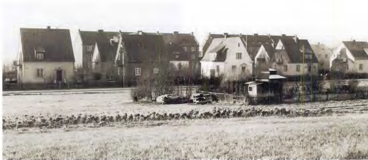
Bebyggelsen i kvarteret Blenda. I förgrunden Backängen, då med något äldre skjul kvar. Foto Wiking Nilsson 1938.
