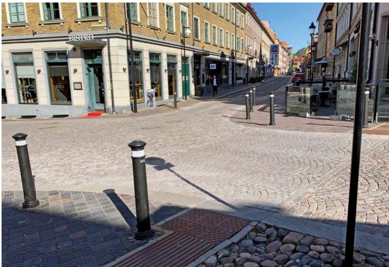
Exempel på anlagt ledstråk i ett skyltat gångfartsområde på Norra Storgatan.
