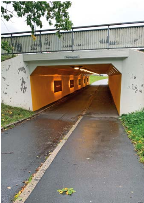
Gång- och cykeltunnel som är belyst både i tunnelns tak och dess ena sida.
