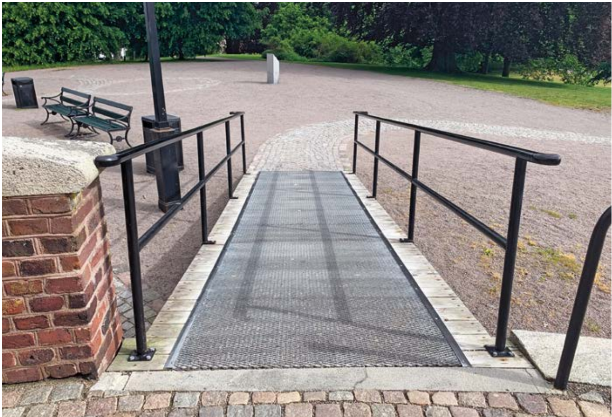
Ramp med handledare på två olika höjder, 900 millimeter och 700 millimeter. Detta för att det ska gå att greppa om ledstången oavsett om man är gående eller sitter i rullstol.
