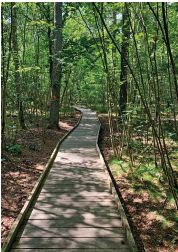
Träspång som öppnar upp för personer som tar sig fram med hjul att komma in i skogsmiljöer. Exempel från Ängelholms kommun.
