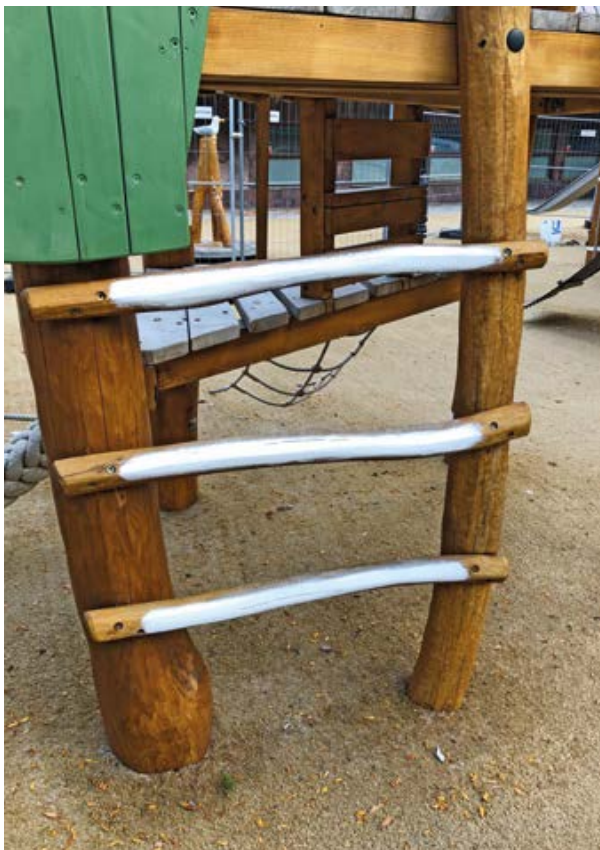
Lekutrustning där Helsingborg själva gjort kontrastmarkeringar vid vissa interaktionspunkter. På bilden visas en trappa som leder upp till ett lektorn.
