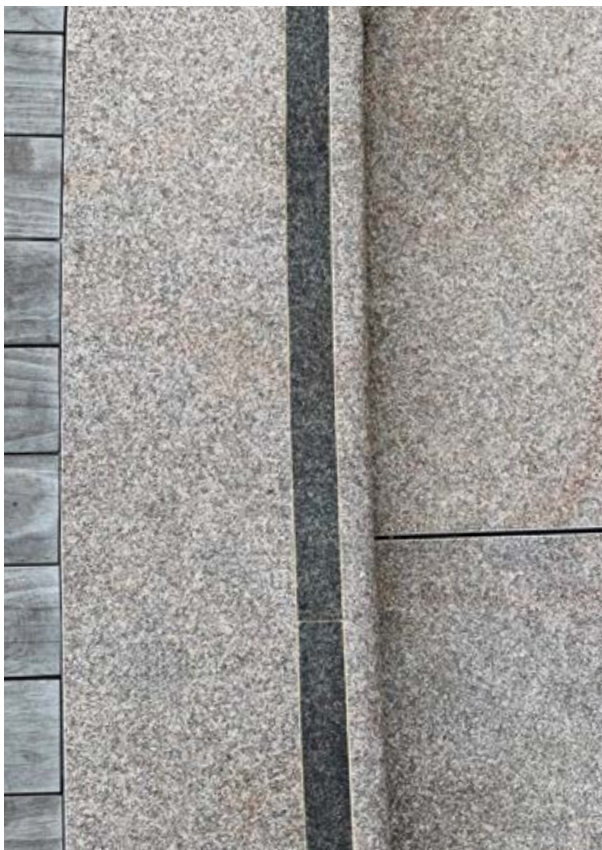
Kontrastmarkering i granittrappa lagd i linje över hela trappsteget. Kontrastmarkering är gjord med diabas som ger en nästintill svart markering.
