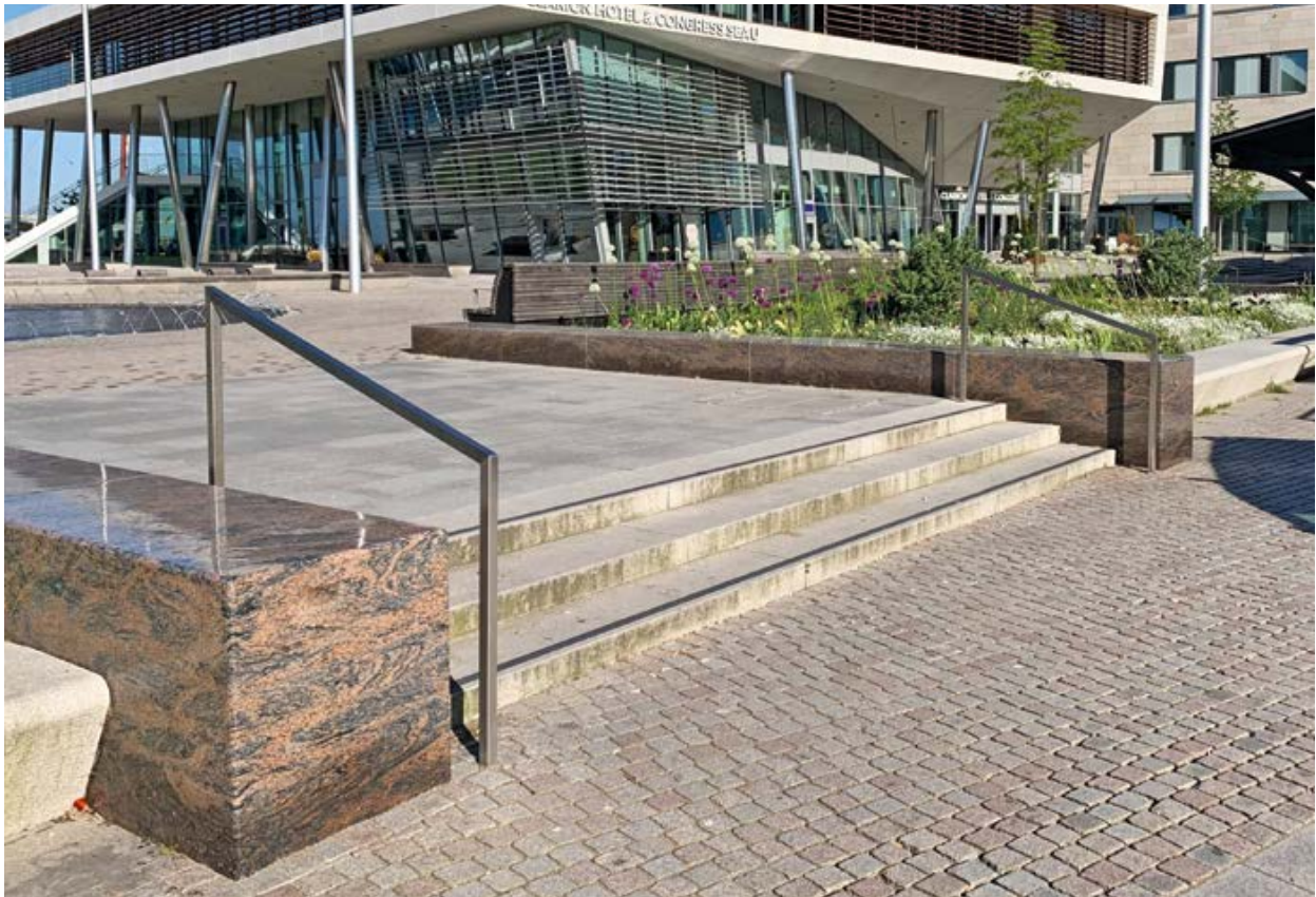
Ledstång i rostfritt material vid SeaU i Helsingborg.
