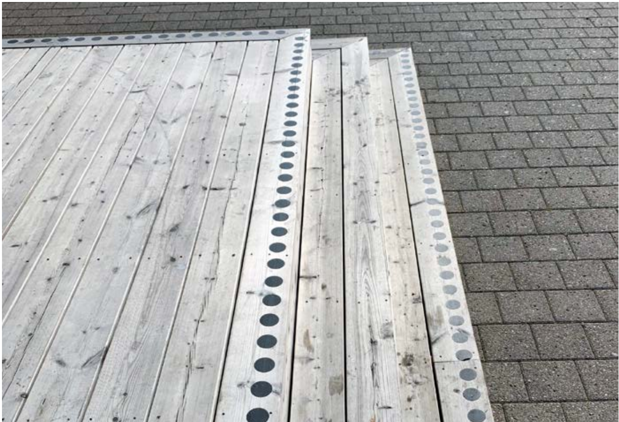
Kontrastmarkering i form av puckar i en trätrappa. Puckarna är gjorda av en typ av plast.
