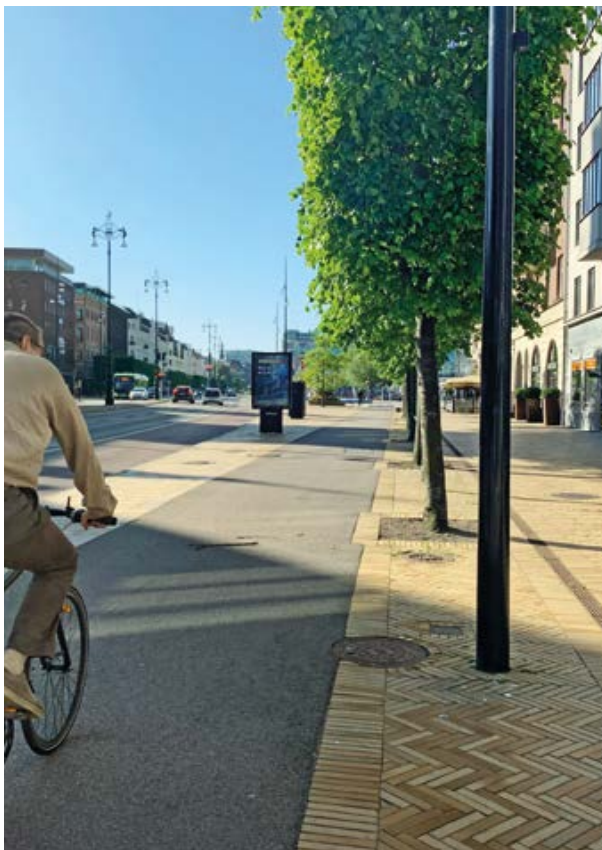
Cykelbana i asfalt som är separerad från gångstråket i tegel. Trädplanteringar och belysningsstolpar är placerade i mitten mellan cykel- och gångbana.
