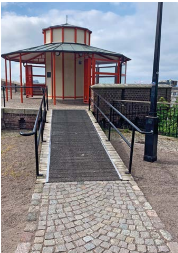
Ramp försedd med nät för att förhindra halka vid blött väder eftersom rampen är byggd i trä.
