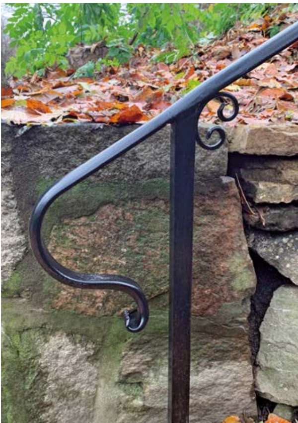
Ledstång i svart smide och med en halvrund överliggare som ger både en tydlig kontrast samt är skön och enkel att greppa om.
