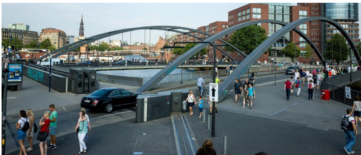
Figur 21 Exempel på tillfälligt skydd med skjutportar vid bro från Hamburg. (Foto: WSP)
