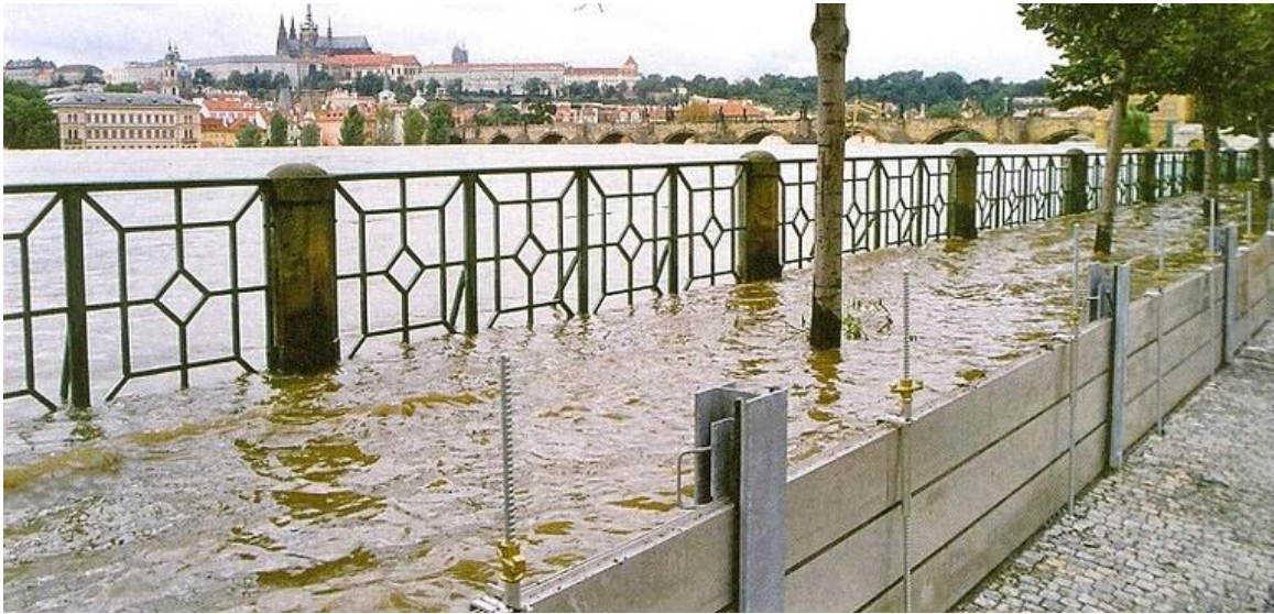
Figur 22 Exempel på mobilt tillfälligt skydd längs floden från Prag. (Källa: Prague TV)
