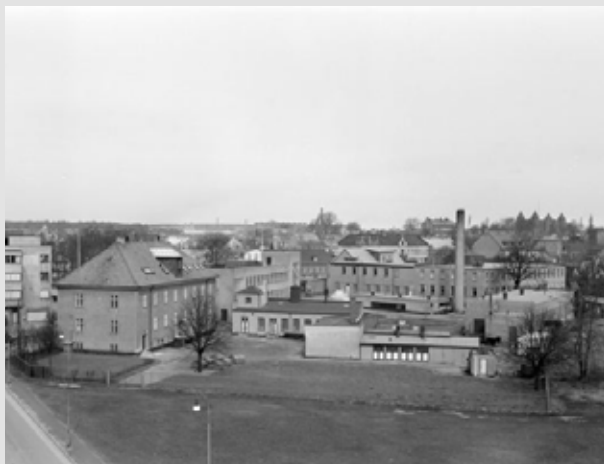
AB Leos industribyggnader från Fredriksdalsplatsen 1955 innan kontorshusen byggdes. Foto: Lindberg.
