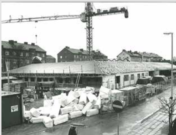
Vårdcentralen i kvarteret Linvären under byggnation 1980. Foto: Helsingborgshem. Bildbanken Kärnan.
