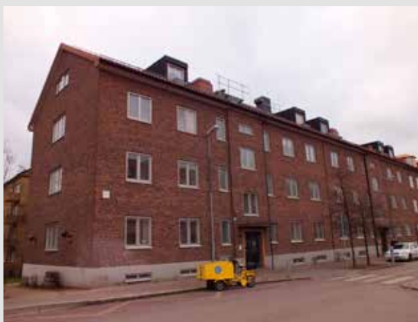
Navaren 2, Norra Stenbocksgatan 9 A–B
