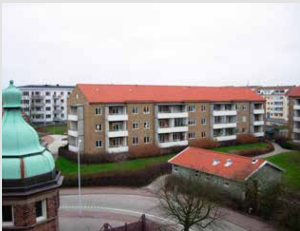
Hus i kvarteret Poppeln mot Bagaregatan. Foto: Karin Gustavsson 2007.
