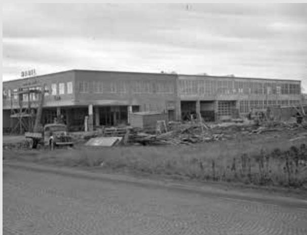
HABIL:s lokaler under byggnation. Foto: Lindberg, 1947.
