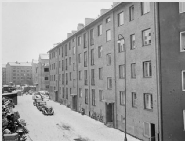
Huset invid Stampgatan 1-5 när det var nybyggt 1954. Foto: Lindberg.
