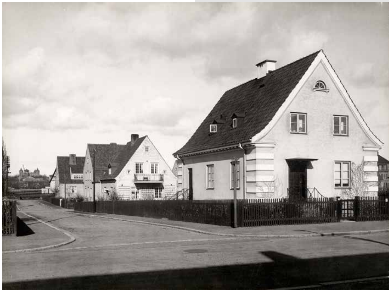
Hus i kvarteret Blåklinten fotograferade 1927. Foto: Bagge.
