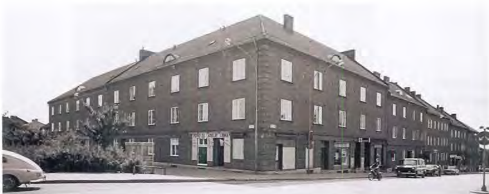
Hörnet av Sturegatan och Furutorpsgatan. Foto Helsingborgs Museum 1975.
