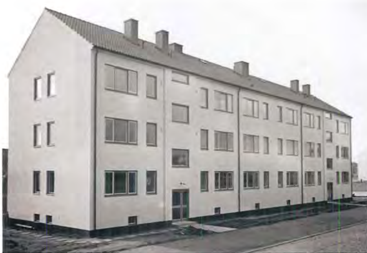
Hus i kvarteret Ödla mot Viskgatan, avsett för pensionärer. Foto Olle Lindberg 1941.
