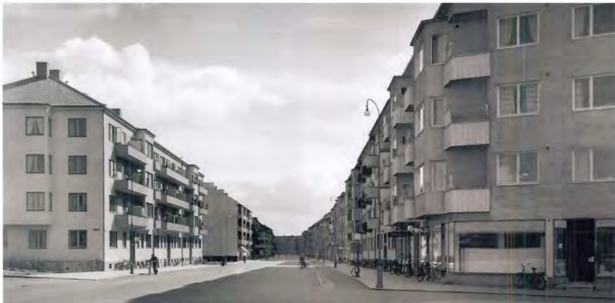
Södra Stenbocksgatan mot söder, i hörnet av Malmögatan och Wieselgrensgatan. Kvarteret Humlan på gatans vänstra sida, på den högra kvarteret Fjärilen. Foto Anker Möller 1940. Helsingborgs stadsarkiv.
