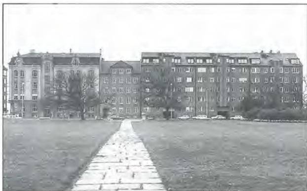
Kvarteret Viadukten från öster. Viadukten 3 är huset i mitten.
