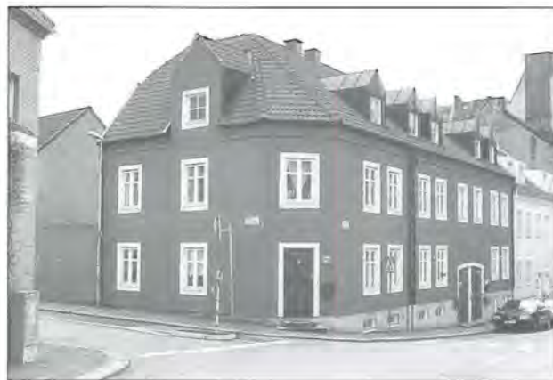
Bebyggelse från 1970-talets slut i kvarteret Hallen.
