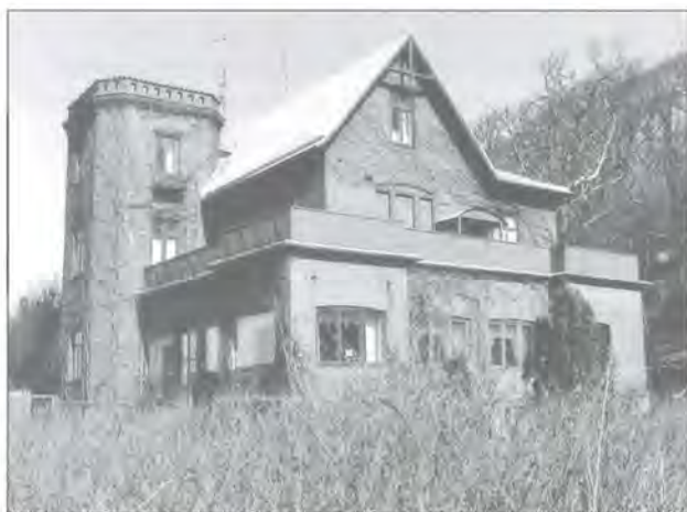
Hovmarskalkvillan, kvarteret Adelsnäs 1, Fårhagevägen 5
