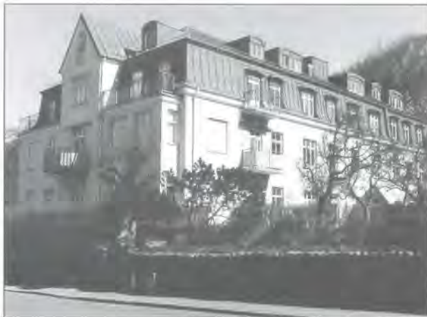
Bäckahus, kv Ankaret Västra 7, Drottninggatan 192
