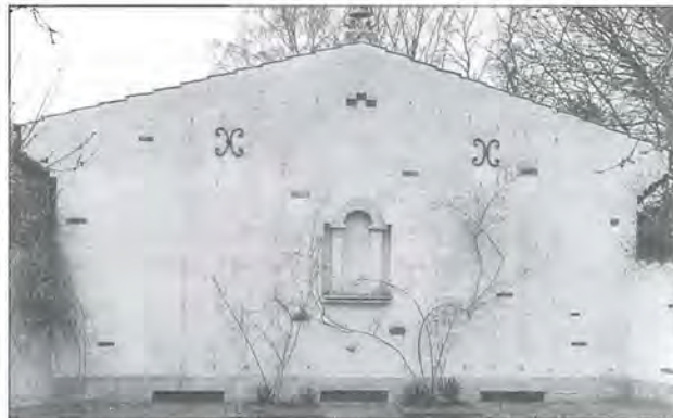
Detalj av villan Kolverket 5, Sofierovägen 37
