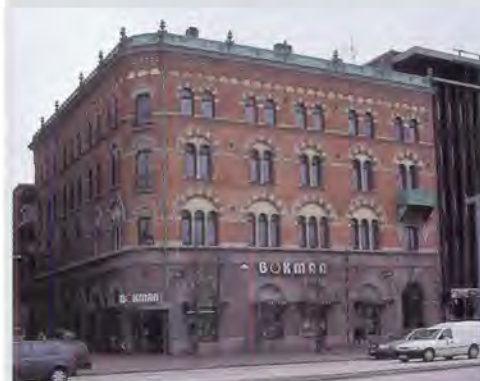
Telegrafan 9 (del av), Järnvägsgatan 3, Norra Kyrkogatan
