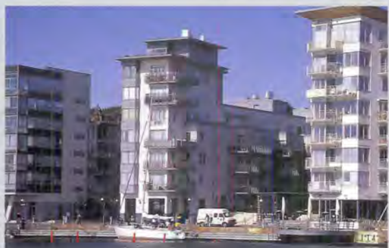
Kronborg 1, (norra byggnaden), Trosshalaregatan 1-5, Kajpromenaden 18
