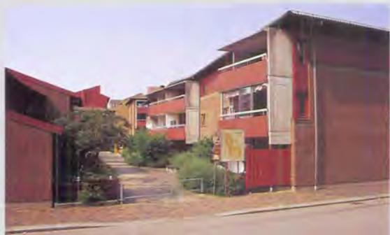
Tyskland 25-27, Nedre Holländaregatan 20-28, Gustav Adolfs gata 10-12, Norra Tvärgatan 1-19
