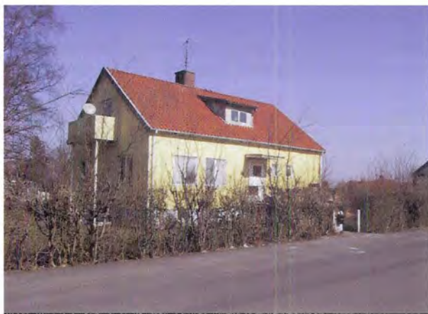
Betinspektörsvilla vid Norra Torggatan uppförd av bruket på 1940-talet. De två betinspektörsvillorna kom, troligen monteringsfärdiga, från Svenska Trähus (Hasslarp 2:75).
