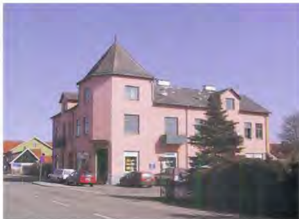
Stadsmässigt vid Västkustvägen. I huset fanns ursprungligen lanthandel, frisörsalong, charkuteri och matservering samt tio lägenheter. Hasslarp 2:64.
