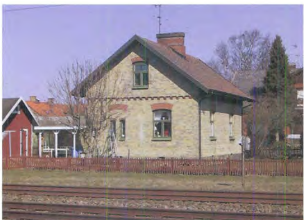
Banvaktstugan är den enda byggnaden som finns kvar av stationsmiljön. Byggnaden kan stilmässigt tyckas vara "skräddarsydd" för Hasslarp, men är sannolikt uppförd efter typritningar (Hasslarp 2:68).
