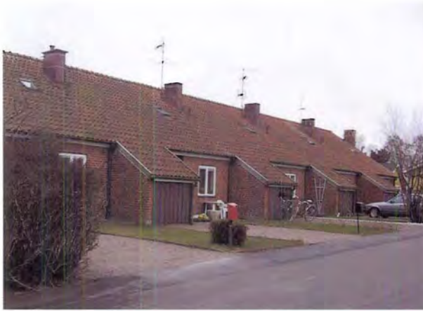
Radhusen i kvarteret Sockersmulan ritades och byggdes av SSA för sina anställda i slutet av 1950-talet. Lägenheterna var på tre rum och kök. Husen står sig väl i jämförelse med mer kända exempel på gruppbebyggelse från perioden.
