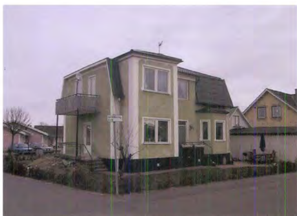
Ytterligare ett exempel på villaarkitektur från början av 1900-talet. Möjligen har samma ritningar använts för båda husen? Detta hus är mer ombyggt än huset ovan. Hasslarp 2:23.
