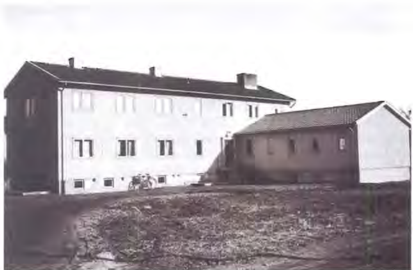
Kampanjehem vid Kampanjegatan fotograferat vid mitten av 1940-talet. Huset är nu rivet.
