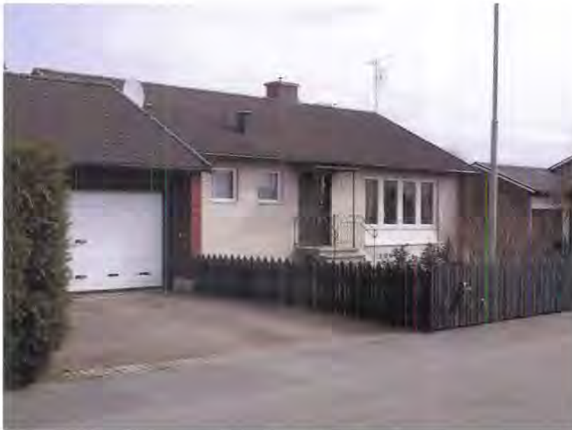
Betongpannor, mexitegel, rött fasadtegel och fönsterbröstning i vitmålad panel är typiskt för 1960-talets villabyggnad. Trädgårdens ekonomihus har ersatts av ett garage (Hasslarp 4:54).
