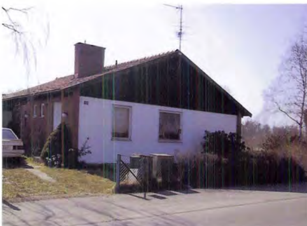
Norra Torggatan framstår som något av brukats gata. Dit förlades det mesta som de byggde av bostäder, så även denna villa. Huset uppfördes 1961, troligen åt någon chef som tröttnat på att bo i de gamla chefsbostäderna i Bruksparken (Hasslarp 2:71).
