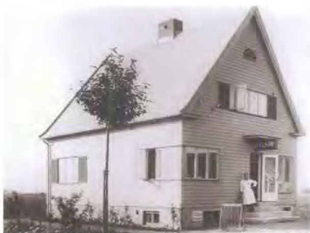
Villa på Västkustvägen 24, som inrymde både frisersalong och skomakeri. Fönstren är placerade på hörnet enligt funkisens ideal, men i övrigt är huset uppfört på traditionellt sätt med brant sadeltak.
