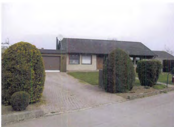
1960-talets utbyggnad skedde med monteringsfärdiga hus från Boro och LB Hus. Grått mexitegel, garage och vintergröna buskar hör till (Signestorp 8:11).
