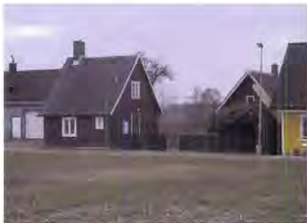
Gathuset Kattarp 1:17 (eller vad som återstår av det). Merparten av boningslängan låg på grannfastigheten och revs. Gränsande till den andra grannfastigheten ligger en ekonomilänga.
