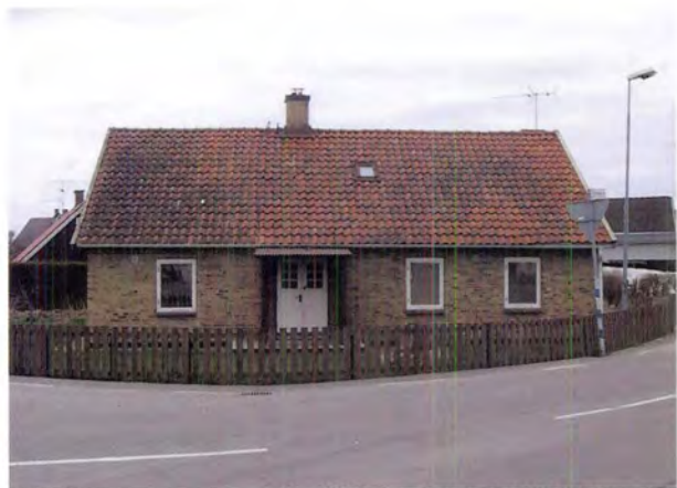
Kattarp 13:22. Äldre tegelhus nära vägen vid kyrkan.
