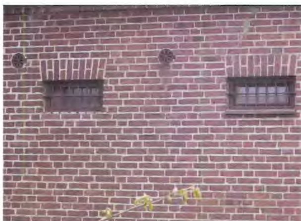
Cellfönster med galler (Loket 1).
