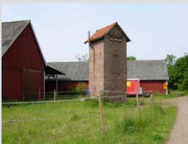
Transformatorstation vid Stall Boson
