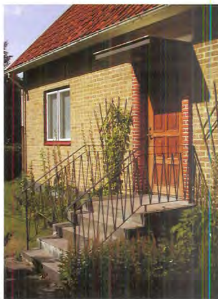
Villa med väl markerad entré med ett enkelt och funktionellt skärmtak och en utkragad tegelomfattning i avvikande färg. Olika färg på karm och båg på fönstren. Höga krav på materialens kvalitet har gjort att byggnaderna har åldrats väl. Stora delar av byggnadsbeståndet från 1950-talet är ännu i mycket gott skick. Mörarp 1:24, kv Kaffekvarnen, Tingshusgatan 9, från 1950
