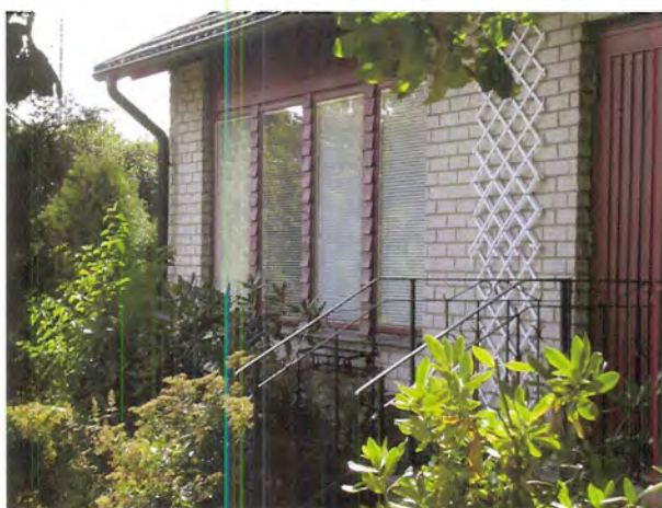
Mexisten och arbetade fönsterpartier i panelklädda fält.
