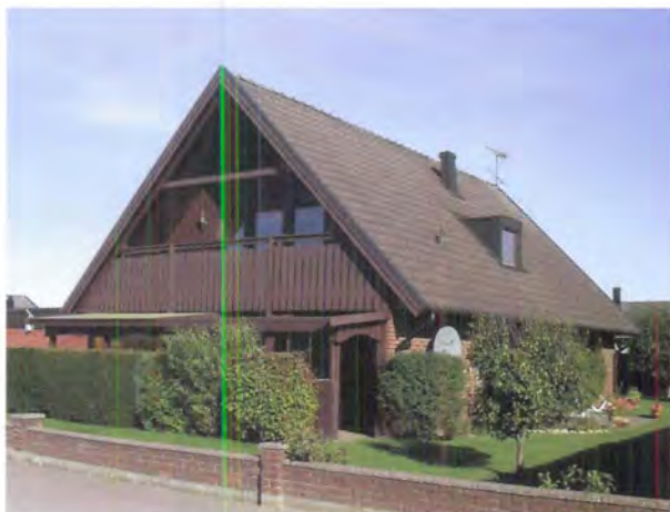
Dominerande gavelparti med kraftigt utskjutande takutsprång och fullbreddsbalkong med terrass under. Kakmättet 3, Rättaregatan 72, byggår 1975
