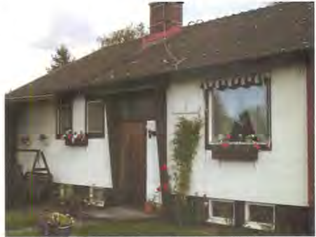
Fasad av synliga Siporexelement, i kombination med rött tegel på gavlarna, lågt sluttande tak och en typisk markerad entré. Mörap 5:18, kv Brödkorgen, Margaretagatan 22, uppförd 1964
