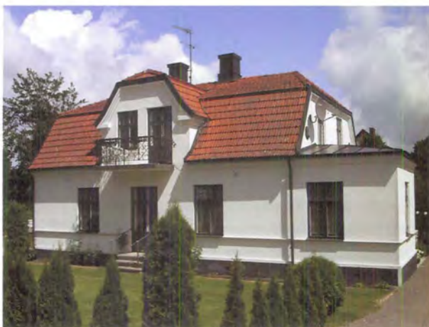
Brutna mansardtak blev populära och är ett sätt att bättre kunna utnyttja ovanvåningen. Fönstren har småspröjsade rutor i de övre delarna, ett tidstypiskt karaktärsdrag. Mörarp 2:11, kv Sockertången, Mörarpsgårdsvägen 1, från 1913
