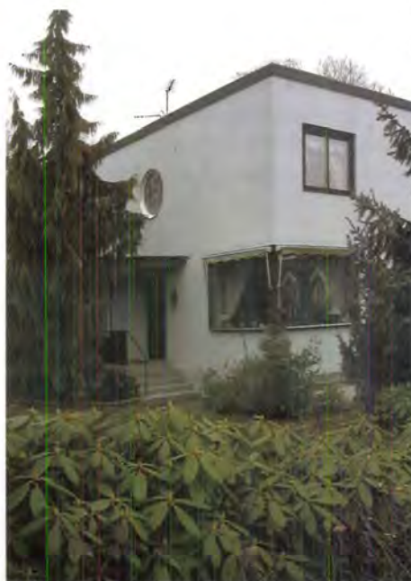
Samma detalj på en funkisvilla med många andra typiska karaktärsdrag, som det platta taket, det tunna skärmtaket över trappan och det runda fönstret på ovanvåningen och den slätputsade fasaden. Mörarp 3:120, kv Skopan, Rosenlundsvägen 26
