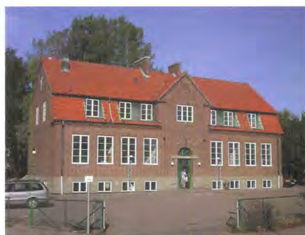
1933 uppfördes den nya folkskolan efter ritningar av Carl Andrén. Byggnaden blev den dittills största i Mörap, och stilen var representativ och högtidlig. Sedan 2003 används byggnaden som skolhem i privat regi. Skänken 4, Brandmansgatan 5
