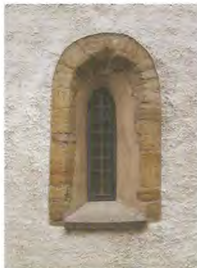
En av de ursprungliga romanska fönsteröppningarna
