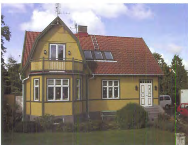
Ett av få hus från epoken med panelklädd fasad. Lingonkruset 25, Gjutaregatan 1
