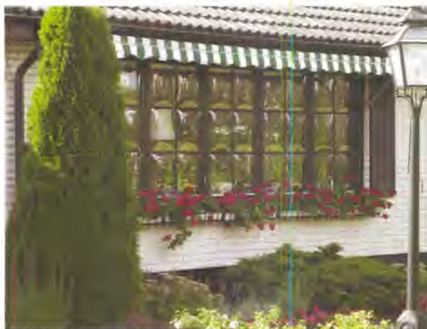
Så kallade övertrycksfönster ger en omisskännlig karaktär av sent 1970-tal. Det är ett material som idag är svårt att ersätta. Korgstolen 2, Bjuvsleden 5B, från 1977
