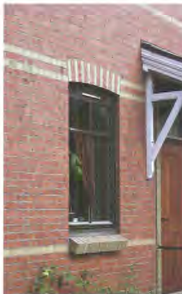
Slagna valv över fönsteröppningarna, mönstermurningar med ljusare eller mörkare tegel, profilerade fogar, utskjutande fönsterbänkar, murverk i kryssförband – typiska drag i det tidiga 1900-talets tegelarkitektur. Gavel på Mörrarp 3:24, Bjuvsleden 22, från 1906
