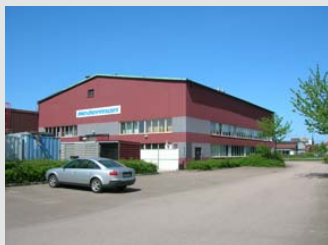
Alfa 5, byggnad B
