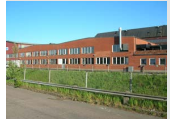
Alfa 5, byggnad C
