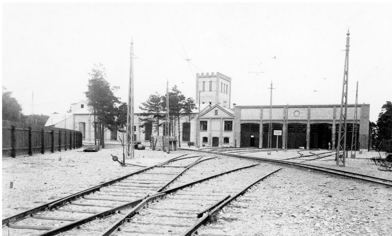
Helsingborg-Råå-Ramlösa Järnvägs nybyggda anläggning vid Triangeln. Foto 1906. Original i Helsingborgs museers samling.
