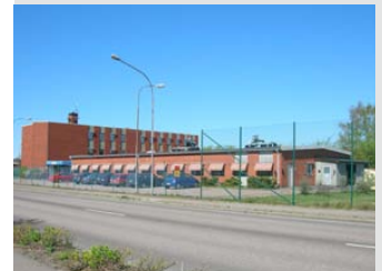
Ejderen 2, kontors- och laboratoriebyggnad
