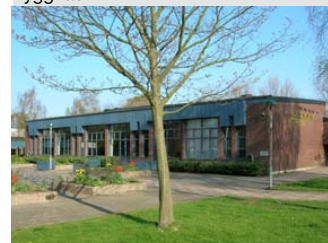
Ljuset 4, Planteringsvägen 139 Byggnad C
