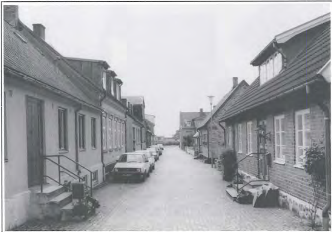
Skepparegatan mot väster. Foto 1991.
