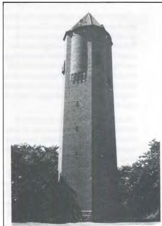
Råå vattentorn byggdes 1916 i rött, hårdbränt tegel. Det försågs med en bastant sockel av kvader-huggen gråsten och en rundbågig sandstensportal. Tornet kom aldrig att tas i bruk då Råå redan 1918 inkorporerades med Helsingborgs stad.
