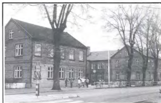
Råå södra skola är det äldsta skolhuset som är i bruk i Helsingborg. Det uppfördes redan 1849 utanför befästningsvallen, men brann senare och har byggts till i flera etapper.
