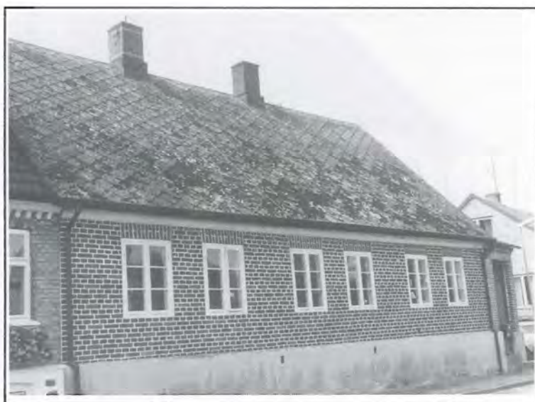
Tak med eternit från 1900-talets början har hunnit bli ett hävdvunnet inslag i fiskelägets bebyggelse och har ofta fått en viss patina. Asbestfritt ersättningsmaterial finns idag för utbyte av skadade plattor.
