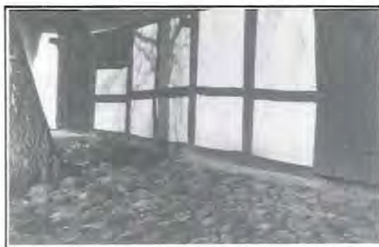
Rååvägen 13, kv Galeasen v:a 7. Detalj av korsvirkeskonstruktion.
