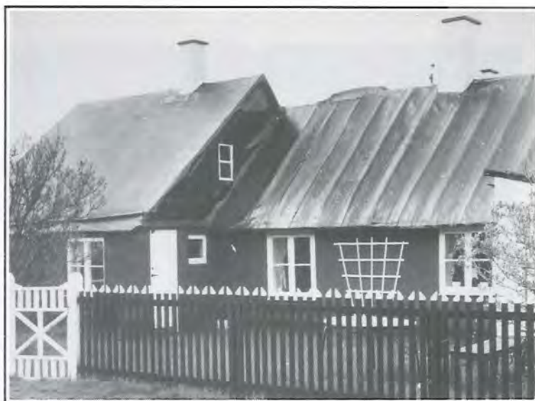
De tjärade papptaken hör fiskelägesmiljön till. De kunde läggas direkt på undertaket eller spikas på trekantssläkt. Ofta kläddes även gavelröset och ibland hela gaveln med papp. Villa Sjösäker, Kustgatan.
