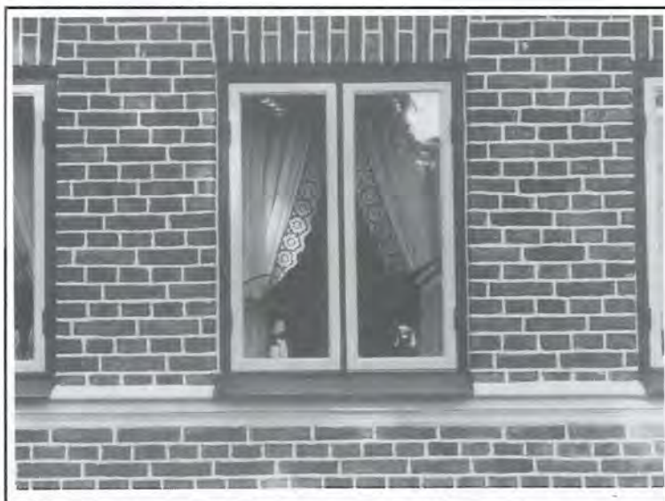
Att måla fogarna vita med kalkfärg har varit en allmän sed på Råå, liksom i flera andra skånska fiskelägen. Härigenom framhövdes murverket - en fogad tegelvägg ansågs "fint" och doldes ej med puts. Östergatan 14.
