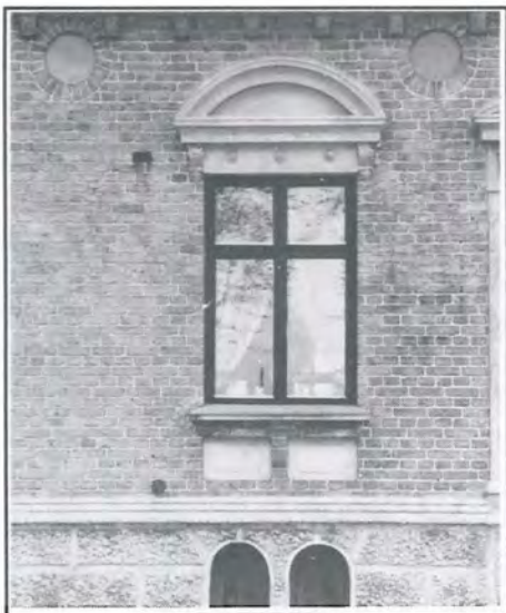
Fönster med högt placerad tvärpost blev moderna under 1800-talets sista årtionden. Kustgatan 36.
