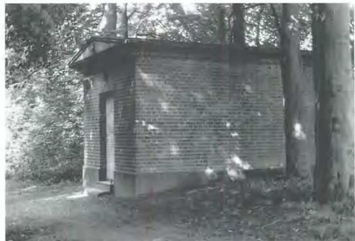
Transformatorstationen på Ramlösa 2:1
