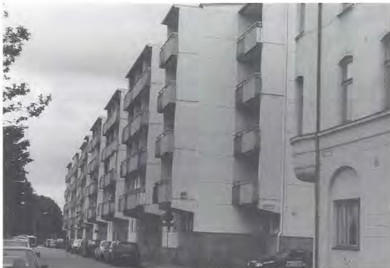
Bild 14 Storskaligt bygge från 1970-talet i kv Viktoria
