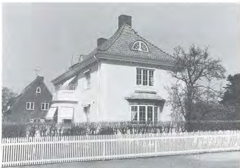
Bild 30 Karl X Gustavs gata 80, Förgätmigej 4, uppförd 1923 efter ritningar av Alfred Arvidsson. Den putsade villan hyser en lång rad detaljer som är typiska för 1920-talsklassicismen. Under det valmade takets svagt utsvängda takfot sitter en tandsnittsge-sims, och hörnen markeras av vertikala linjer.
