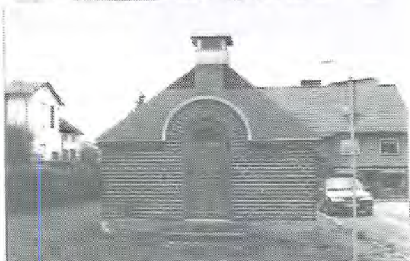
Pumpstation vid Örebrogatan. Det är en gedigen och väl utformad byggnad.
