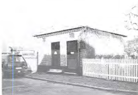
Transformatorstation i kvarteret Björnen
