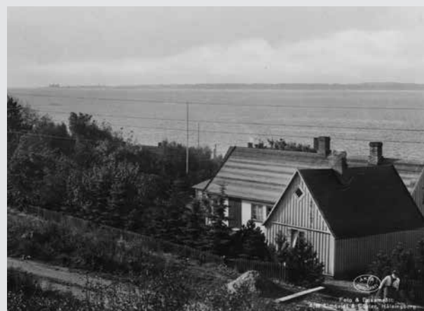
På ett gammalt vykort syns båtbyggaren Magnus Perssons hus som troligen uppfördes redan 1747 och är därmed ett av de allra äldsta husen i Hittarp. Bild från Helsingborgs museers samlingar.
