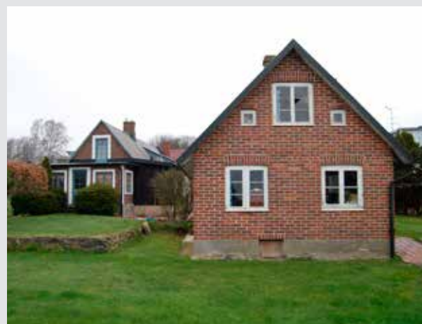
Snett bakom huvudbyggnaden, ligger det gamla brygghuset från 1912 med grunden från de gamla stallarna kvar till vänster i bild. Bakom syns den äldsta delen av boningshuset från 1860-talet.
