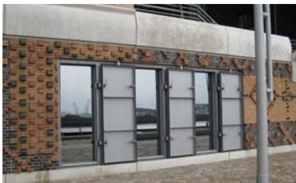
Vattentät fasad i Hafencity, Hamburg, White/WSP
