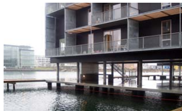
Byggnad på pelare. Teglverksbolmen, Köpenhamn, White/WSP
