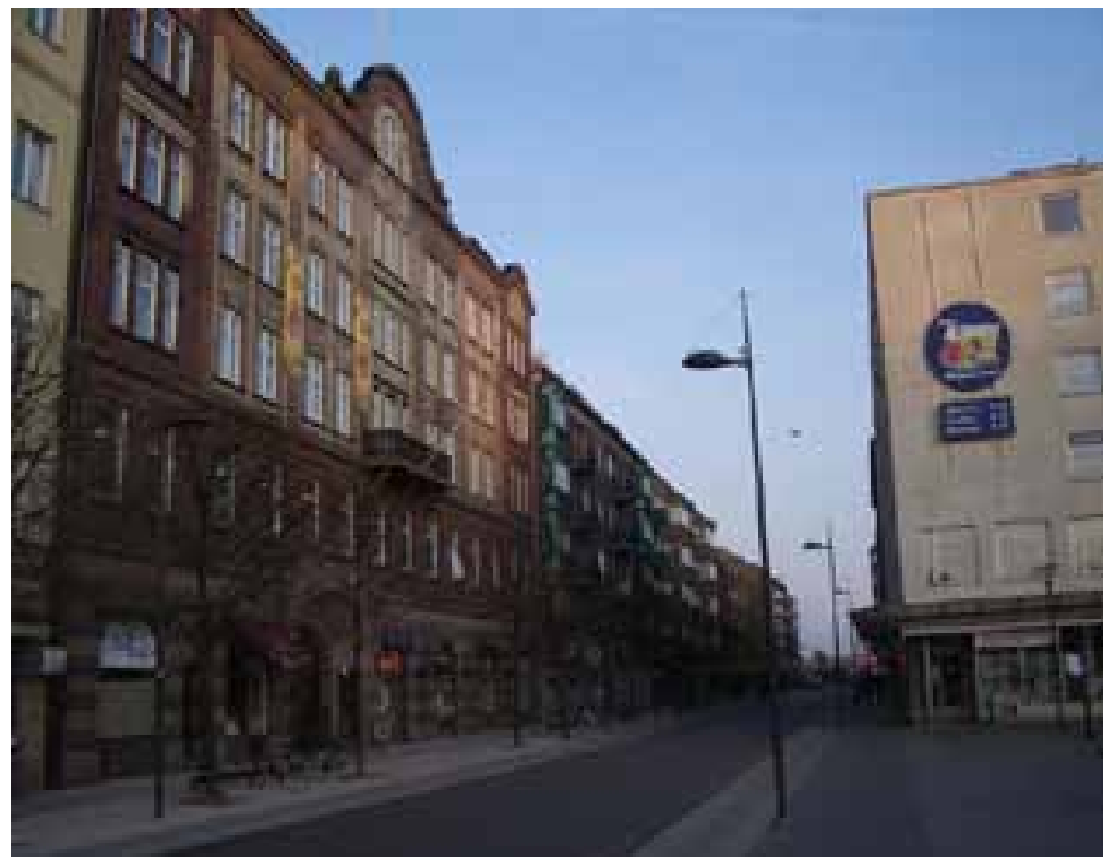
Folkets hus-byggnaden vid Södergatan 2009. I övrigt dominerar idag bebyggelse från 1940-70-talet.
