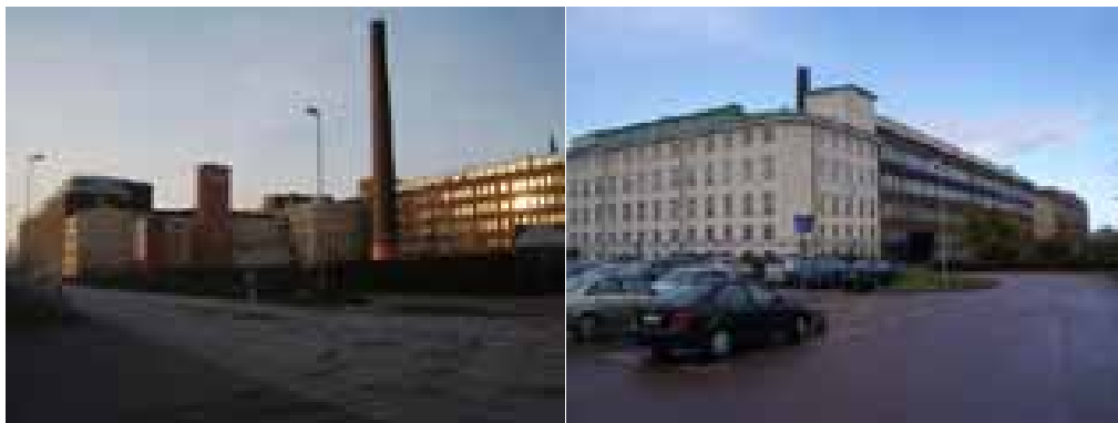
Gamla Tretornfabriken, idag Campus Helsingborg och kontorslokaler
