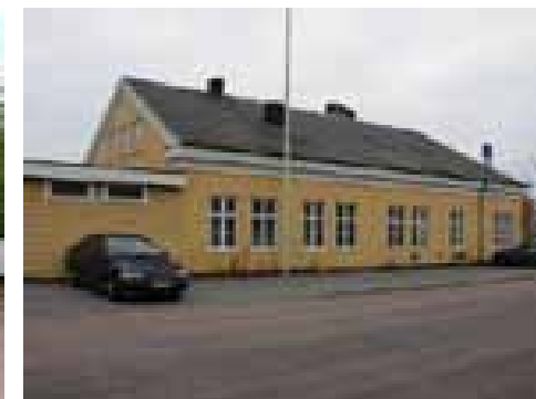
Lagerbyggnad, Kv Arabien 9
