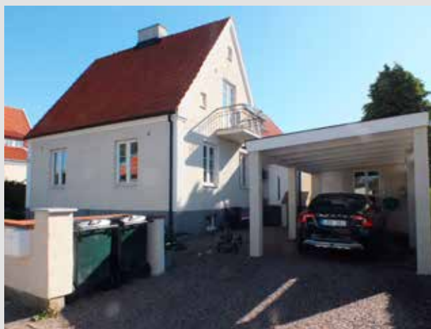
Tegen 19. Sigridsgatan 23, "Villa Valborg/Walborg"
