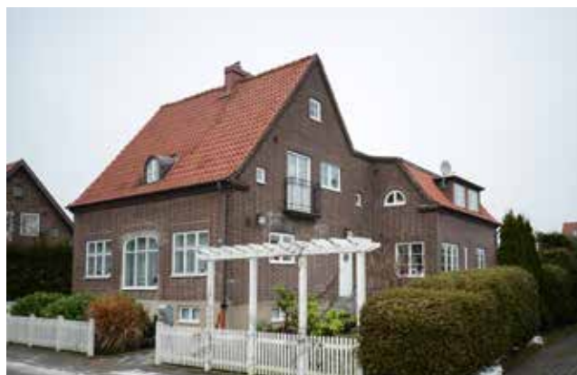
Byggnaden i kv. Torvan 19 på Per Eskils gata var ursprungligen affär och tvåbostadshus men byggdes om med samlingslokal för S:t Eskils kapell som huserade där mellan 1956 och 2003. Idag är det bostadshus. Foto Andreas Paulsson.
