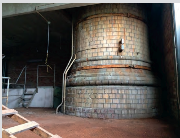
Basen till den äldre skorstenen som nu är inbyggd.
