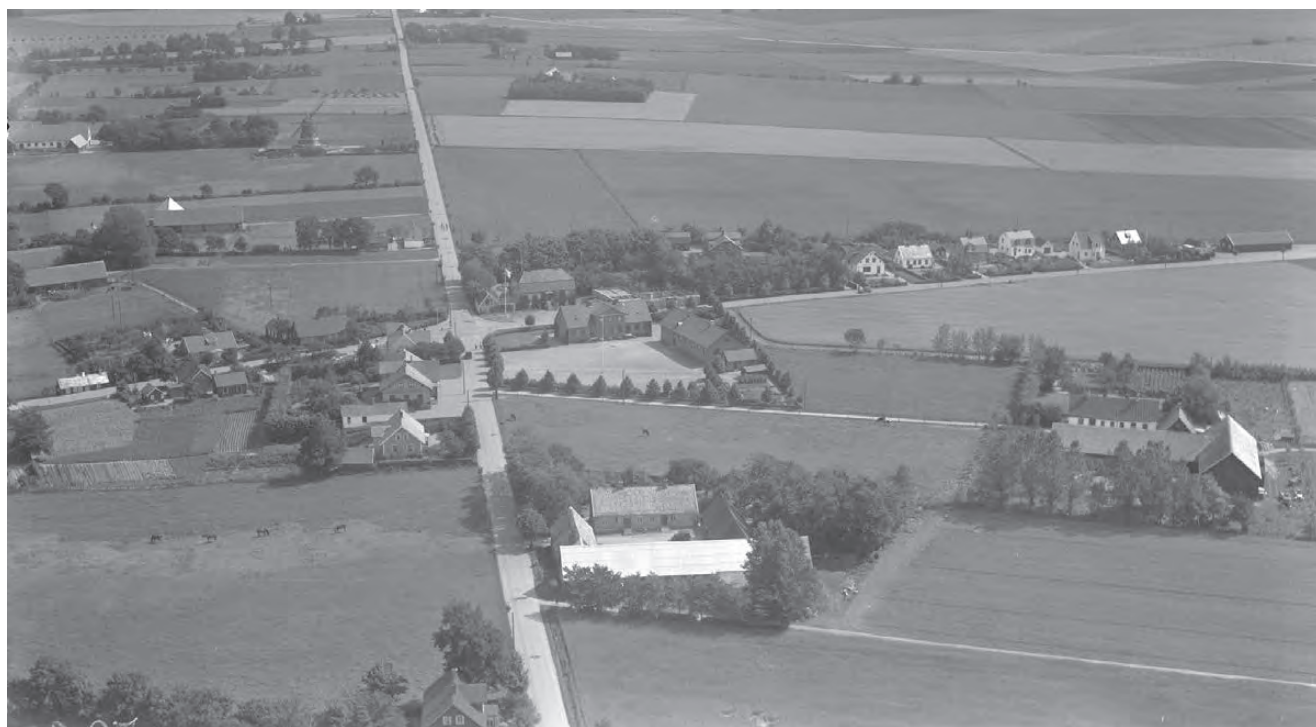
Flygbild över Fleninge år 1938. Till höger om vägkorset ser man gästgivargården, kommunalhuset och i trädningen skymtar det på 1910-talet uppförda ålderdomshemmet (nu rivet) och längs vägen till höger de sex villorna från 1930-talet. I förgrunden längs vägen den gård som revs när Lantmännen etablerade sin verksamhet. Foto: Kulturen. KM 85976.9411.
