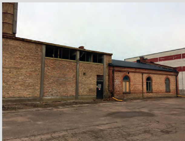
Det äldre pannhuset ligger till höger i bild
