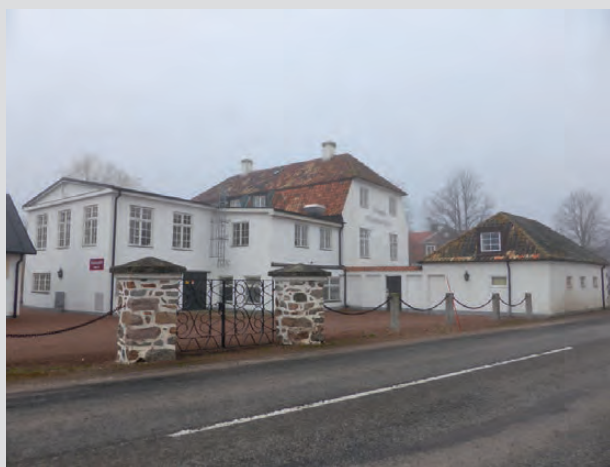
Flygelbyggnaden till vänster i bild utgör byggnad av kompletterande värde för miljön och grindstugan till höger i bild särskilt värdefull bebyggelse enligt PBL 8:13 §.
