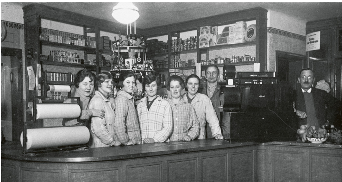
Fältabackens inköpsförenings butik med personal, vid hörnet Hässleholmsgatan och Söderköpingsgatan. Butiken upphörde omkring 1949, byggnaden är idag kraftigt förändrad. Bild från Helsingborgs stadslexikon.
