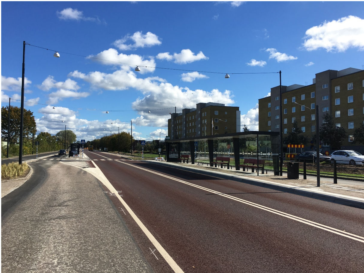
Vasatorpsvägen efter ombyggnation för HelsingborgsExpressen.
