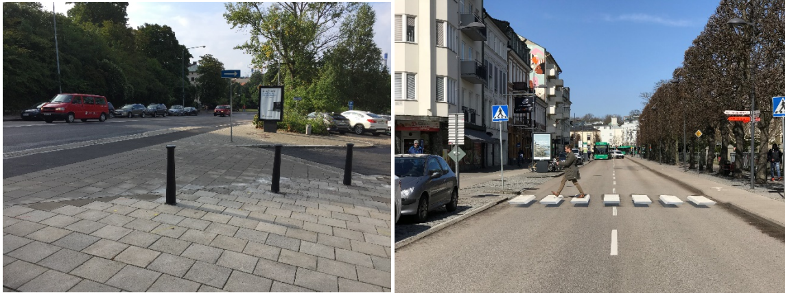
Trafiksäkerhetsåtgärd för cykel på Lilla Bergaliden samt 3D-övergångsställe vid Södergatan.
