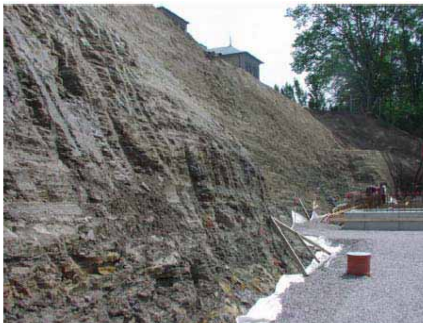
Figur 11.2 Exempel på schakt i sedimentärt berg utan stödkonstruktion.
