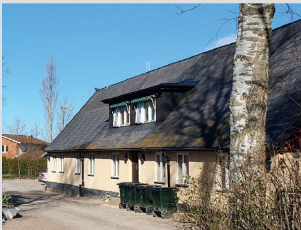
Nyvångs gård 1, 2 och 3. Nyvångsvägen 89
