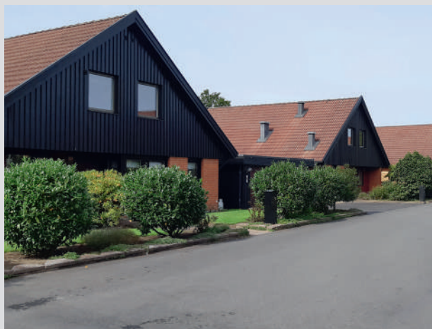
Takfönstret, Takfoten, Takbjälken, Takkupan, Taklisten. Mistelgatan
