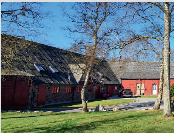
Nyvångs gård 1, 2 och 3. Nyvångsvägen 89
