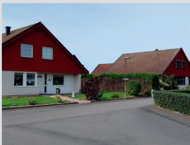
Takfönstret, Takfoten, Takbjälken, Takkupan, Taklisten. Mistelgatan
