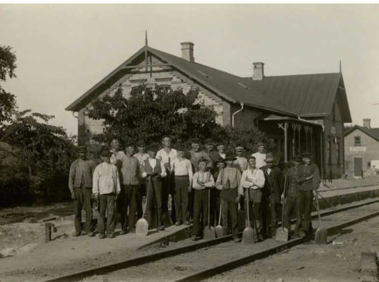
Foto från 1907. Arbetare framför det nya stationshuset. Foto: Helsingborgs museers samlingar
