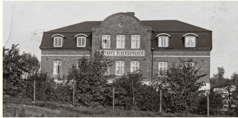
1 Kattarps äldre domshem, byggt 1913. Byggnaden finns fortfarande kvar strax intill mossen och används som församlingshem.
