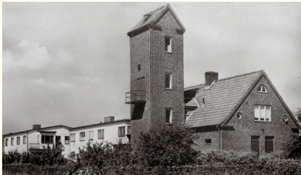
4 Brandstationen i Kattarp, byggd 1934.
