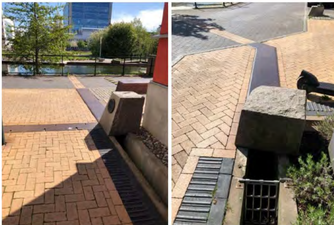
Exempel på ytlig avledning med körbar övertäckning från Västra hamnen i Malmö. Rännan leder dagvatten från kvartersytor till en öppen dagvattenanläggning på andra sidan vägen. (Foto: Viveka Lidström)
