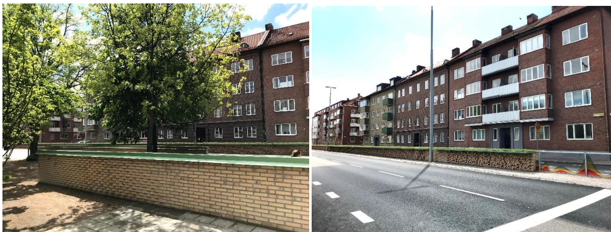
De nya bullerdämpande tegelmurarna på Södra Stenbocksgatan som byggts klart under 2020.
