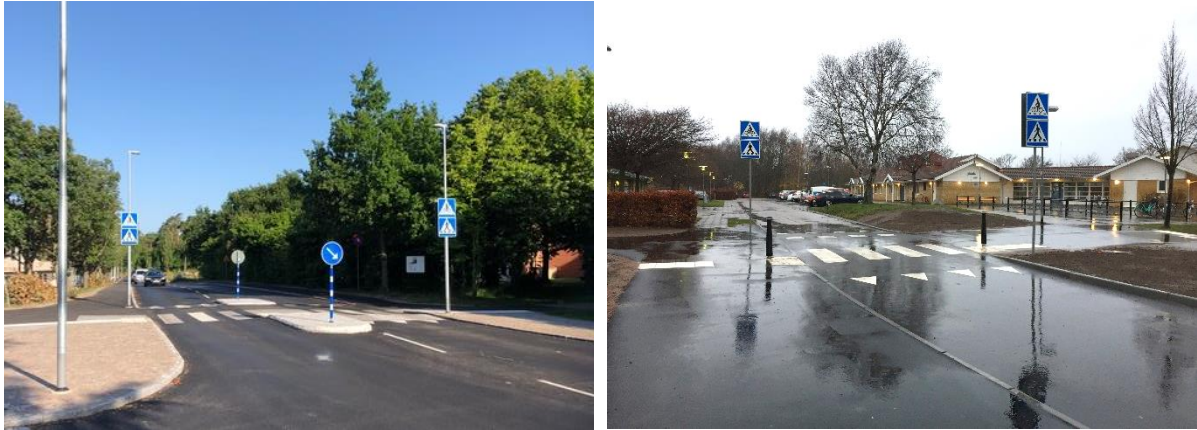
Exempel på trafiksäkerhetsåtgärder 2020. Till vänster ny upphöjd cykelöverfart på Hittarpsvägen vid Laröds skola och till höger ny upphöjd cykelöverfart vid Gläntanskolan i Ödåkra.
