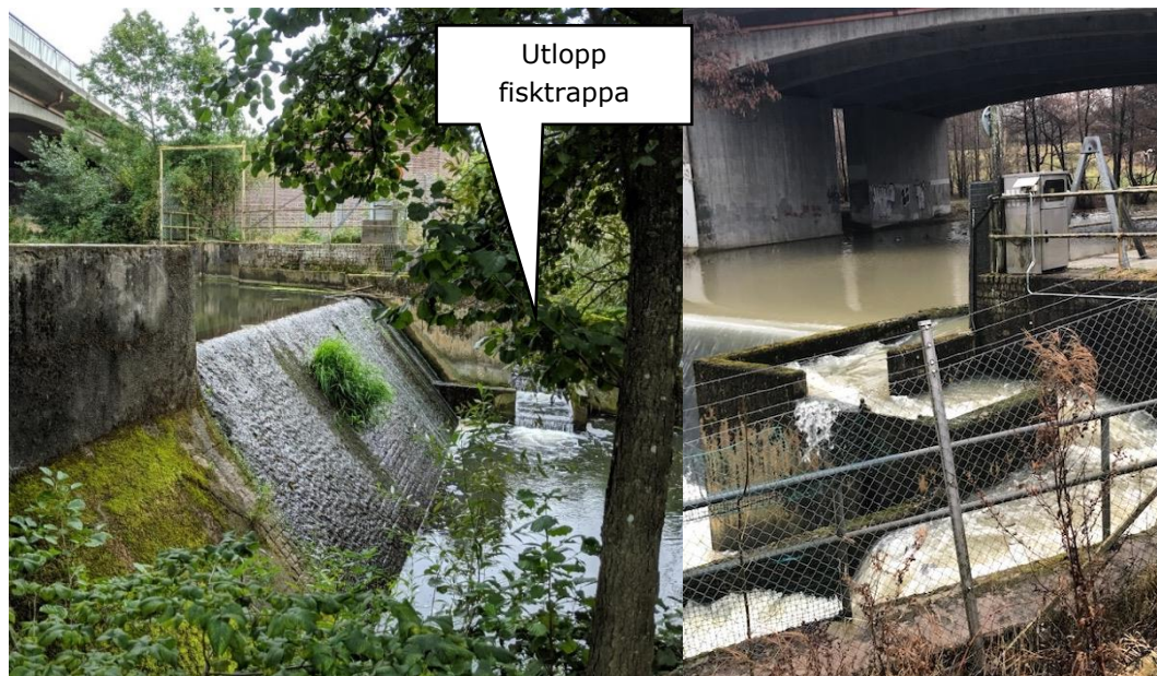
Figur 2-4. Görarpsdammen och fisktrappan. På fotografierna syns europavägen som passerar strax uppströms dammen. Pumphuset skymtar i bakgrunden på vänstra bilden. Det vänstra fotografiet är taget från höger strand medan det högra fotografiet är taget från vänster strand.
