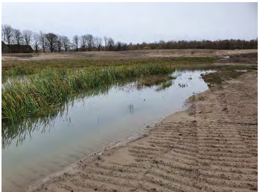
Vy mot bullervallen mot Ängelholmsleden med våtmarken längs Kanongatan i fonden
