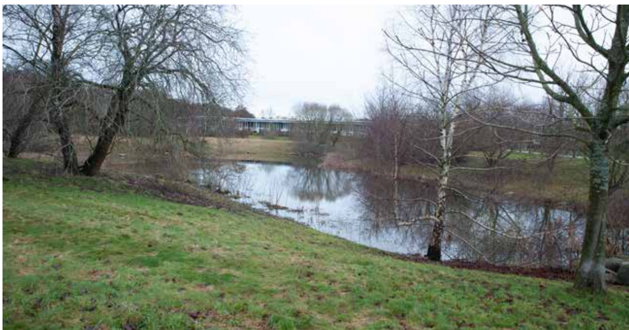
20. Foto Huvuddammen, även kallad Slutdammen, placerades vid en befintlig sänka i anslutning till Kungshultsskogen och samlar upp dagvattnet från övriga dammar och dikesstråk innan det släpps vidare till Pålsjö bäck.
