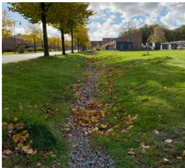
32. Foto makadamdiken och svackdiken har placerats både längs gator, i gräsytor och inom bostadskvarteren. De hanterar dagvatten men bidrar inte till upplevelsen av vattnet.
