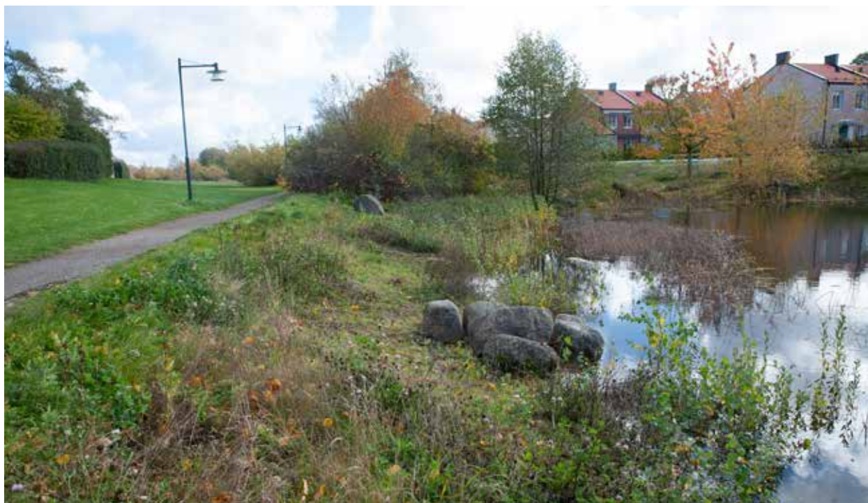
35. Foto De flesta dammar, bäckstråk och diken i Mariastaden har flacka slänter vilket är avgörande för känslan av kontakt med vattnet. Här är dessutom gångvägen dragen nära vattenytan. Här syns även inslag av stenblock som hittades vid schaktning i området och som använts som ett element i dammar och diken.
