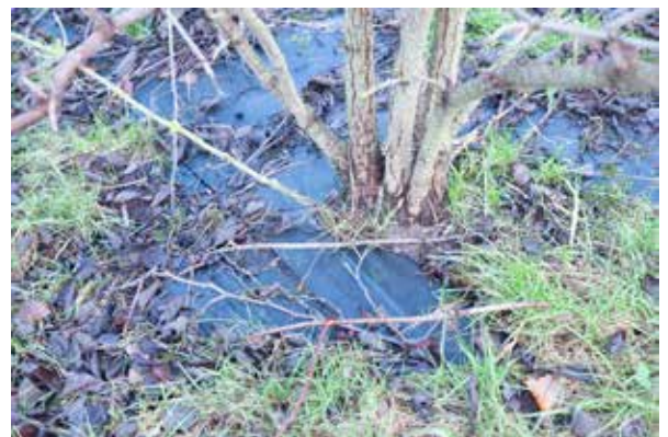
36. Foto ogräshämmande markduk i svart plast är av fel sort och har inte förmultnat som var tanken. Detta drar ner intrycket av anläggningen.
