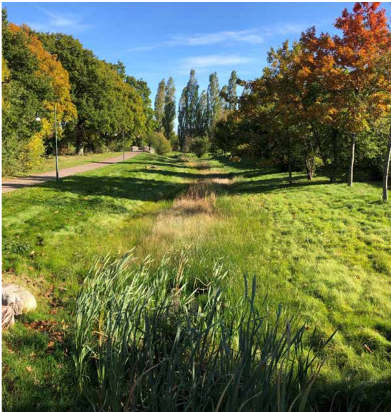
52. Foto Ytligt avrinningsstråk som vid större regn kan fyllas med vatten
