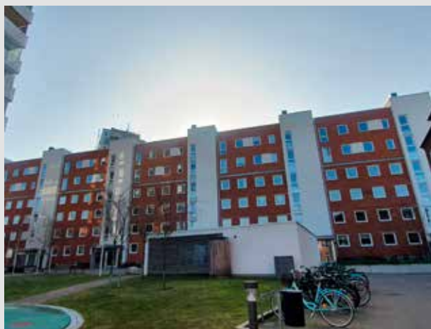
Idun 4, Hammarbergsgatan 1–3, 5 A–B och 7–9
