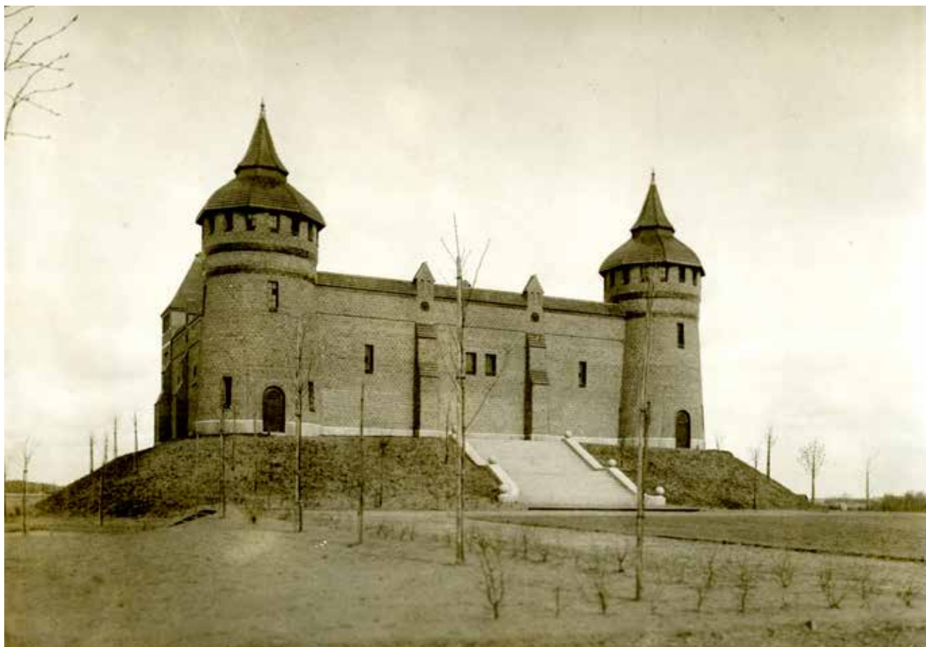
Ringstorp's vattentorn. Tidpunkt för fotografiet okänd men sannolikt i anslutning till byggnadens färdigställande med tanke på storleken på planteringarna utanför. Källa: Helsingborgs museum nr 34-80c
