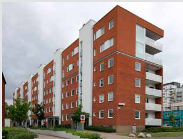
Idun 4, Hammarbergsgatan 1–3, 5 A–B och 7–9
