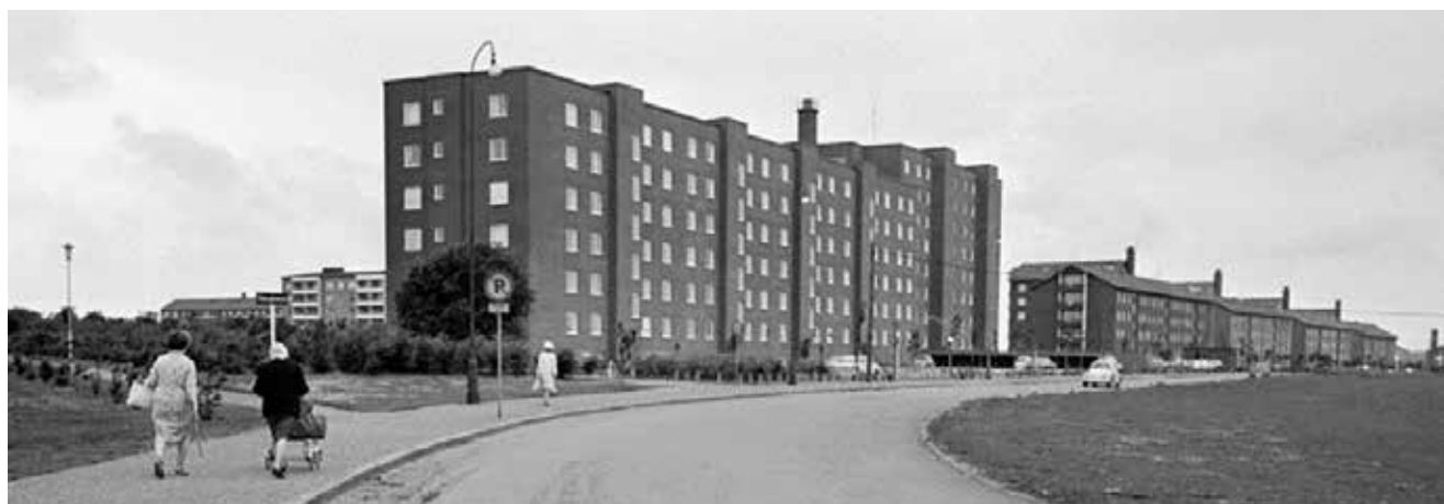
Närmast i bild det massiva flerbostadshuset på Sleipner 1. Foto är taget år 1966. Källa: Helsingborgs museum nr 1097-2015:17
