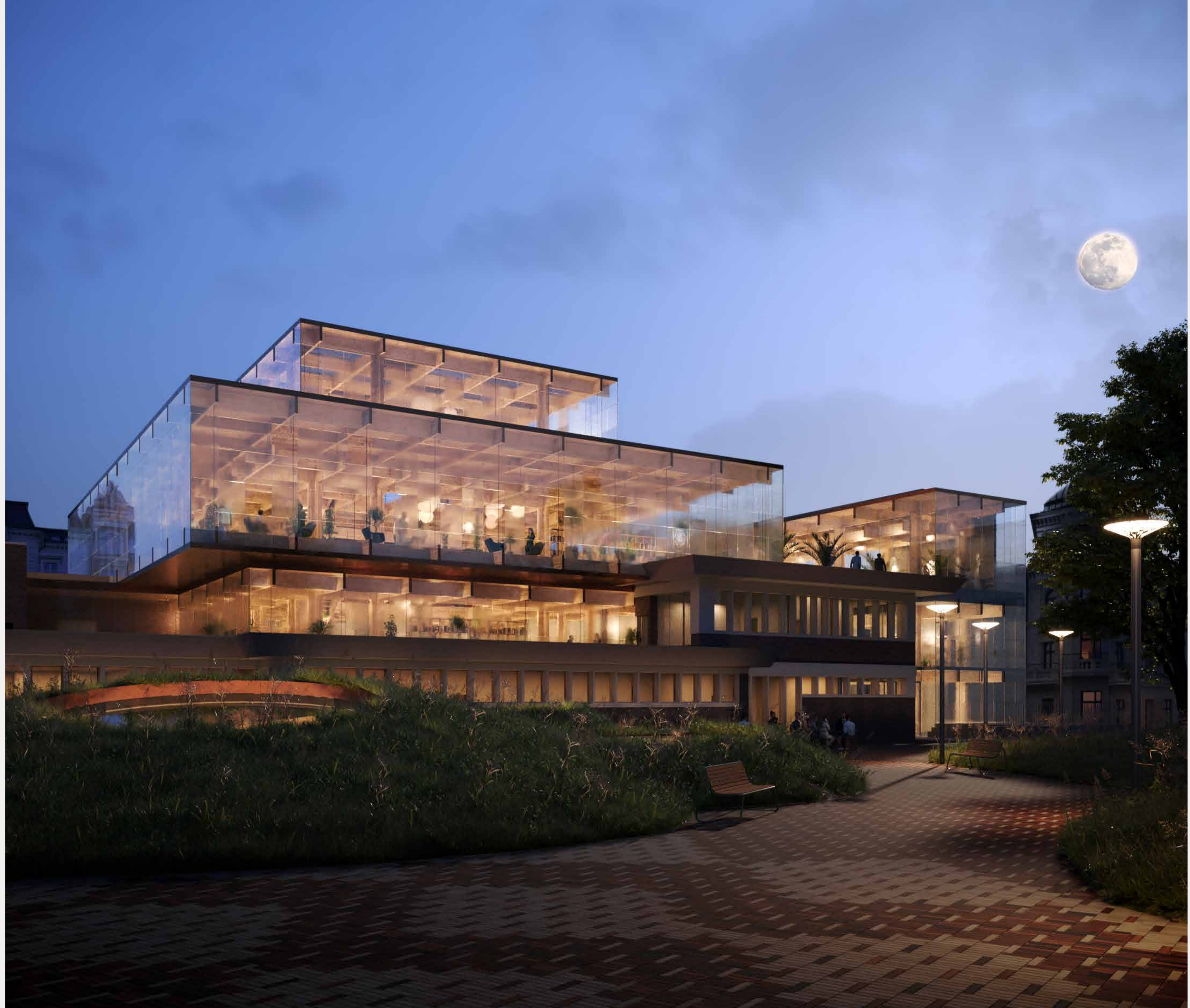
Genom en kompakt dubbelglasfasad skapas ett mönster med olika transparens och samtidigt omhändertags solavskärmningen mot väster och söder.
