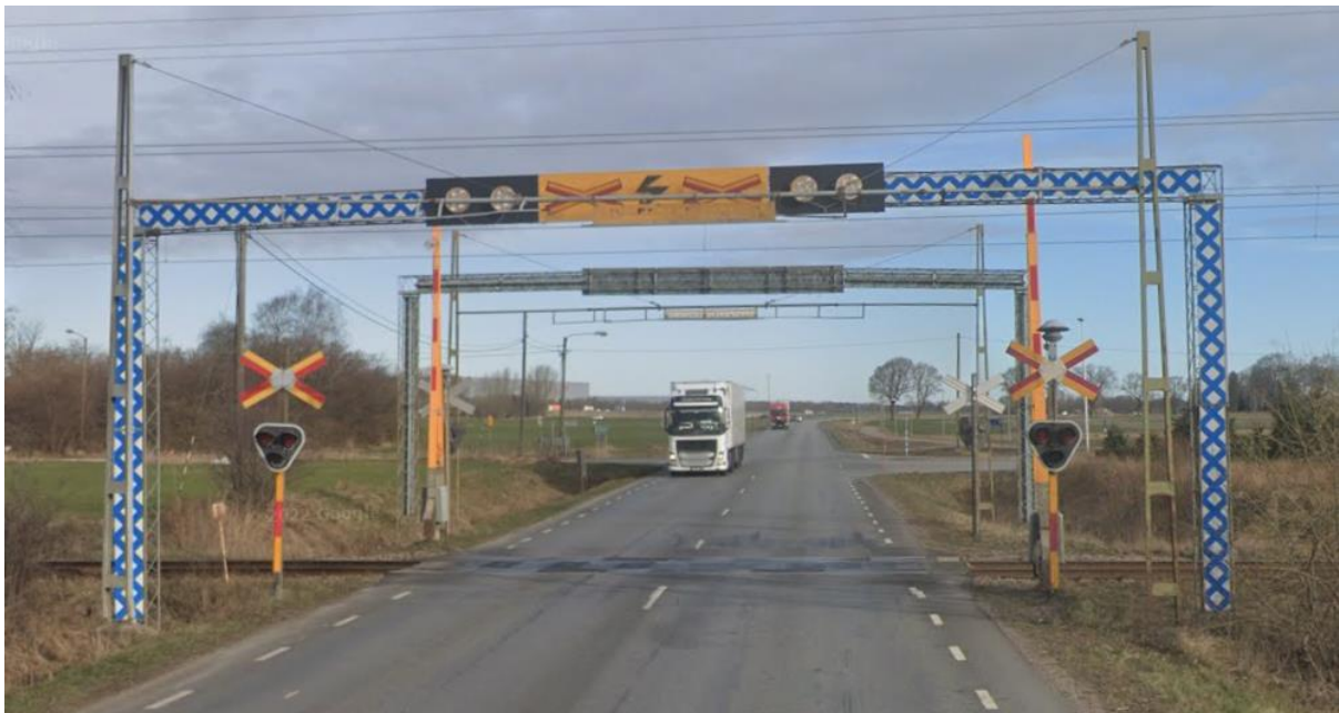
Figur 35. Plankorsning mellan Skånebanan och Rausvägen. (Källa: Google 2022)
