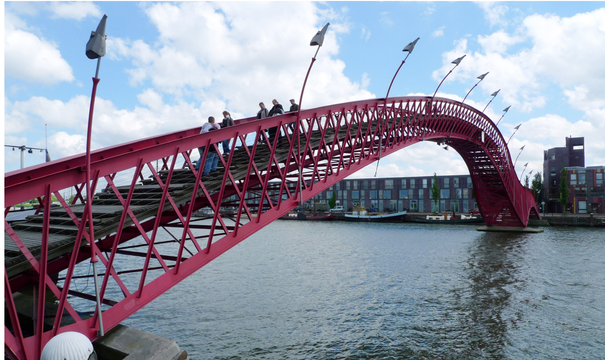
Nödvändig koppling över vattnet men också ett landmärke som skapar identitet. "Python Bridge", arkitekt West 8, Amsterdam, Nederländerna. Bildkällor: Sydväst
