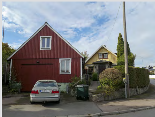
Gantofta 1:58 och 1:59, Pålstorpsvägen 1
