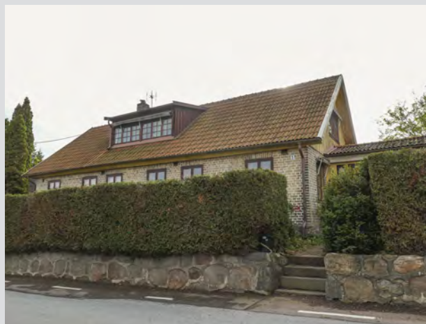
Gantofta 1:58 och 1:59, Pålstorpsvägen 1
