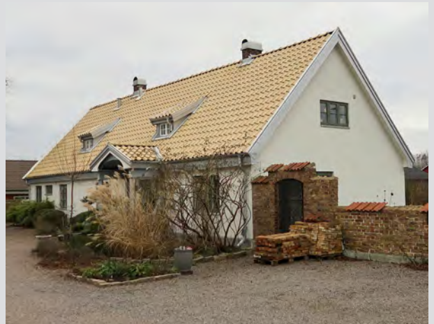
Gantofta 1:228 och 1:365, Pålstorpsvägen 15
