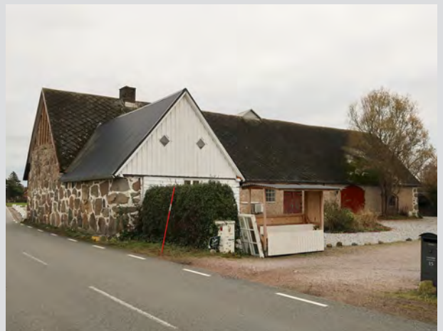
Gantofta 1:228 och 1:365, Pålstorpsvägen 15
