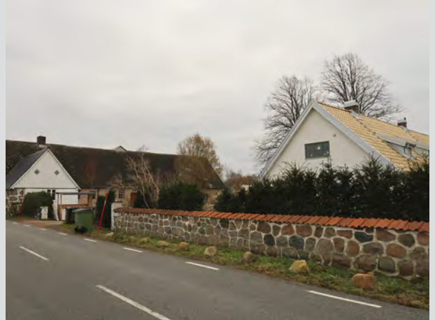
Gantofta 1:228 och 1:365, Pålstorpsvägen 15
