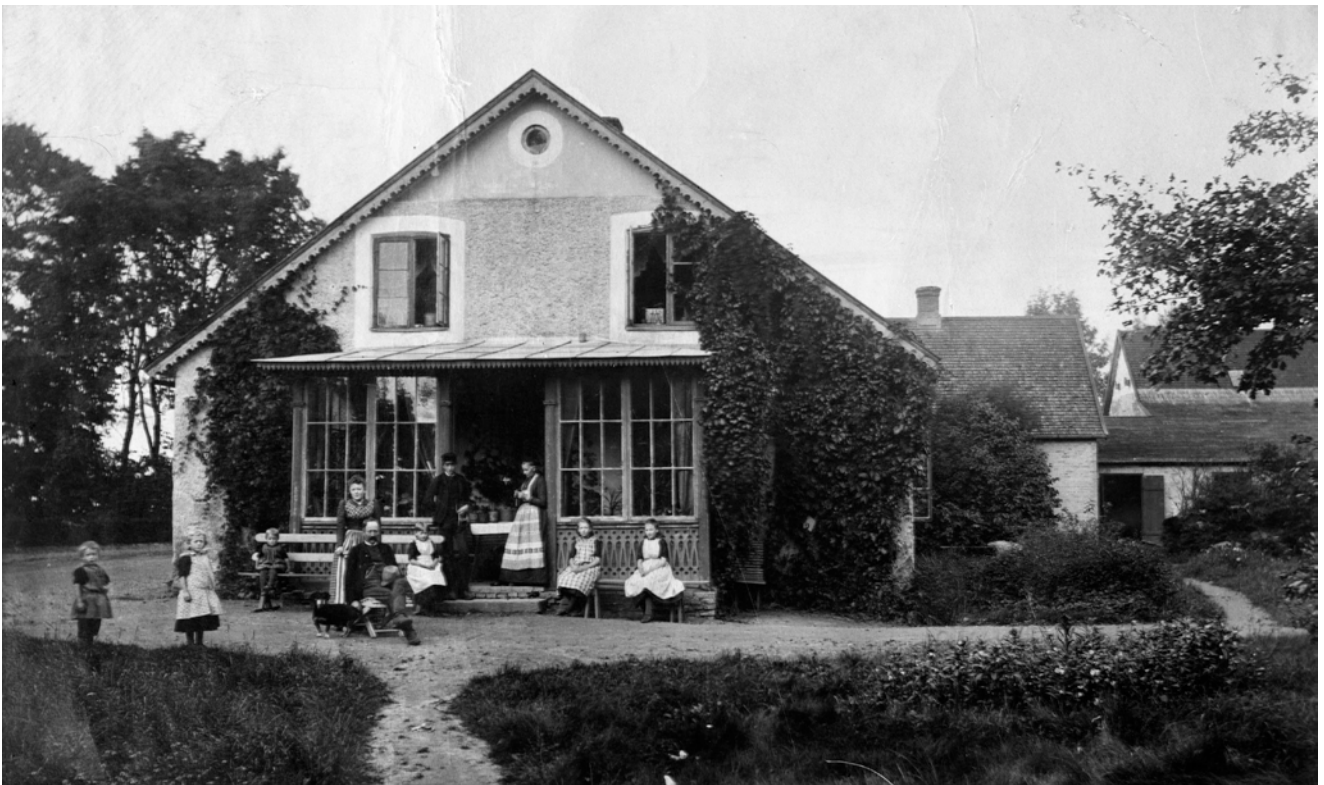
Fotografi från Vallåkra gård 1891. Detta är den ursprungliga huvudbyggnadens södra gavel. Källa: Helsingborgs museum 2494-2020
