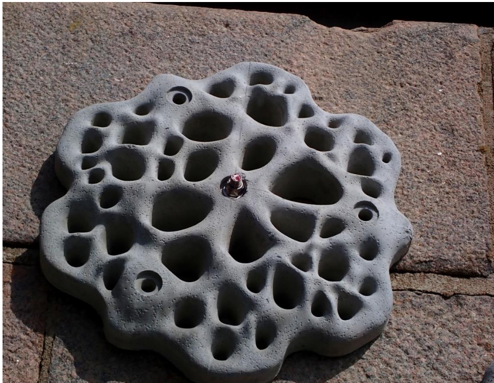
Figur 7. Påväxtplatta över vattenytan vid levande havsvägg.
