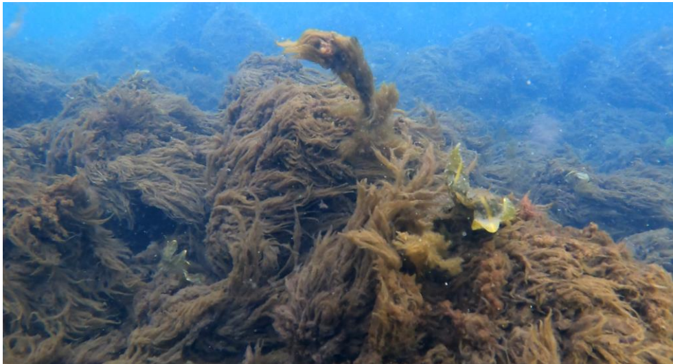
Figur 6 Revet bestående av stenblock med kraftig påväxt
