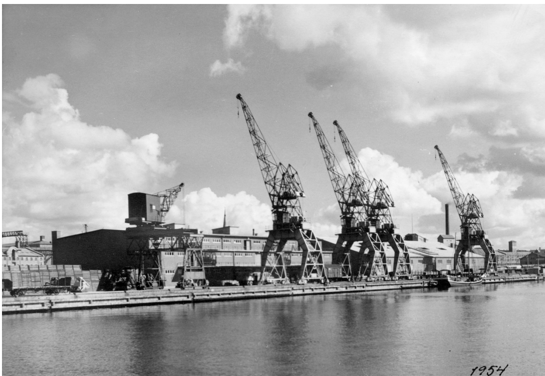
4.2 Fotografi från 1954 av Magasin 405, vy från väster med kranar på kajen.
