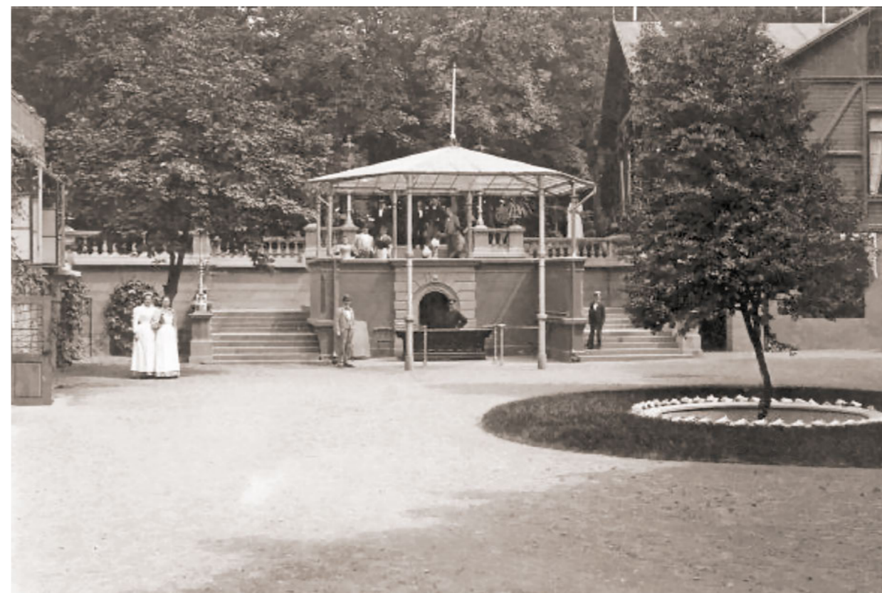
Anläggningen vid Sofiakällan år 1900. Byggnaden som skyttar till vänster revs i samband med Hälsövägens breddning 1901. Senare försvann även den till höger. Carl Dahlquist, Helsingborgs museum.
