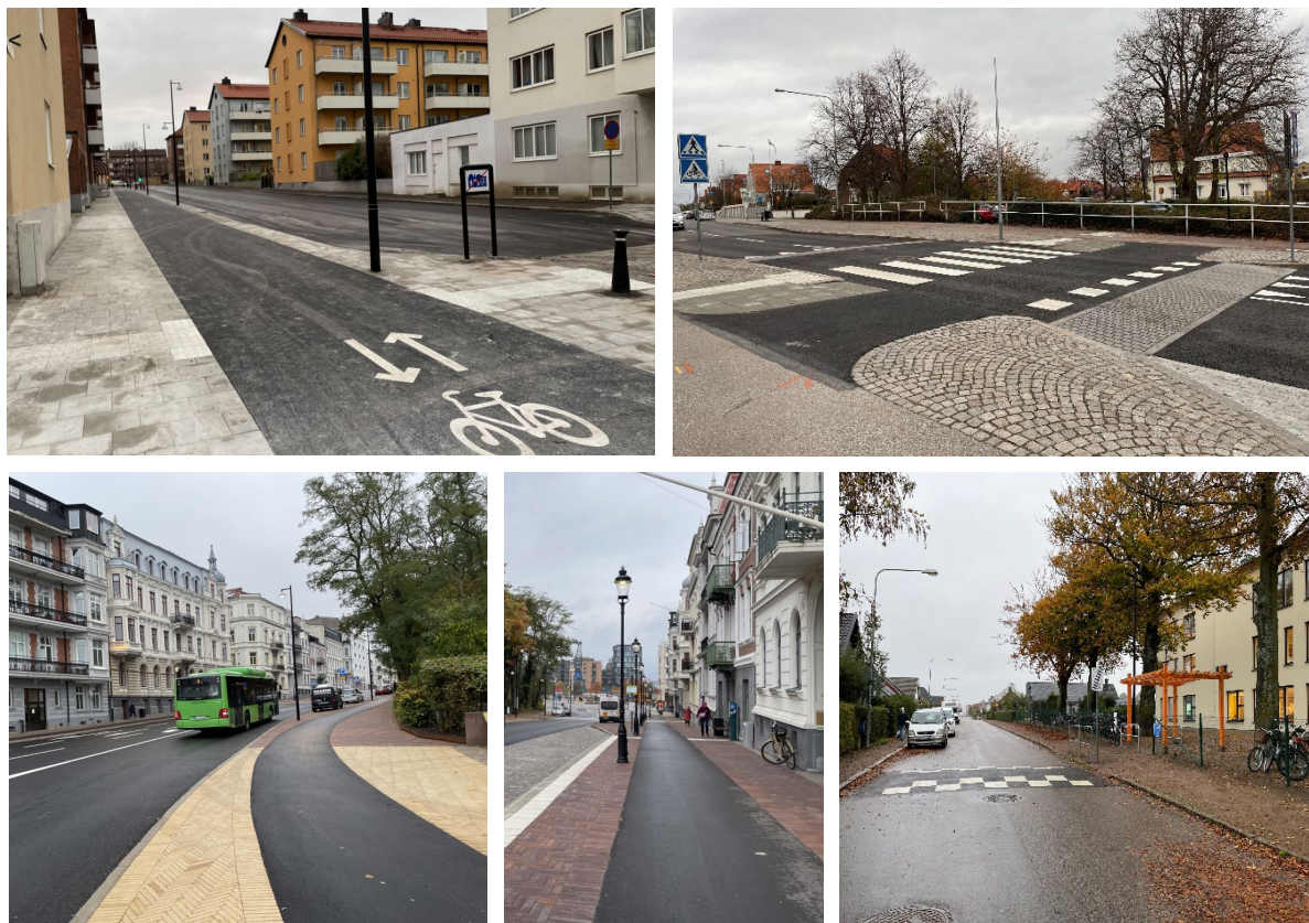
Separerad cykelbana på Övre Eneborgsvägen, upphöjt gång- och cykelövergångsställe på Pålsjögatan, Två separerade cykelbanor på Trädgårdsgatan och fartgupp vid Husensjö skola.
