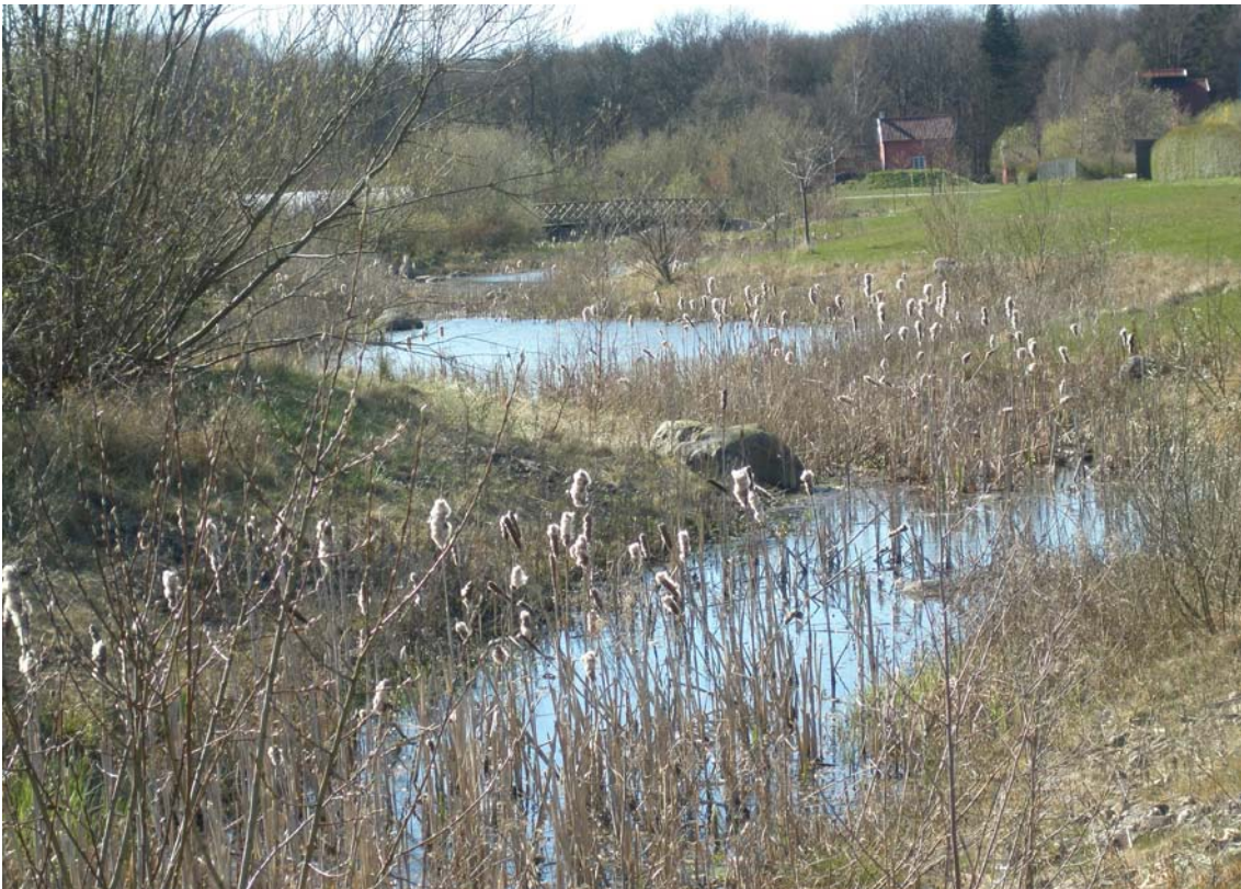
Dagvattendam. Bilden är tagen i Mariastaden, Helsingborg och är exempel på både rekreativa och biotopiska mervärden som kan tillskapas i förbindelse med fördröjning av dagvatten.
