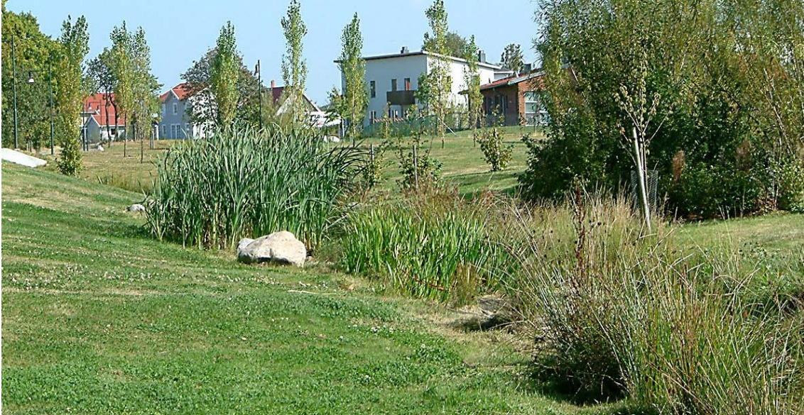
Dagvattendam. Bilden är tagen i Mariastaden, Helsingborg och är exempel på både rekreativa och biotopiska mervärden som kan tillskapas i förbindelse med fördröjning av dagvatten.
