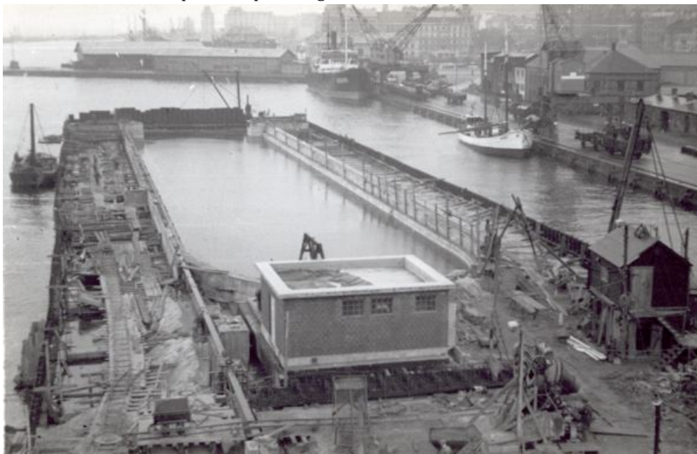
4.2 Den nuvarande torrdockan under uppförande. I förgrunden syns pumphuset som hör till torrdockan. Foto från Helsingborgs museers samlingar.
