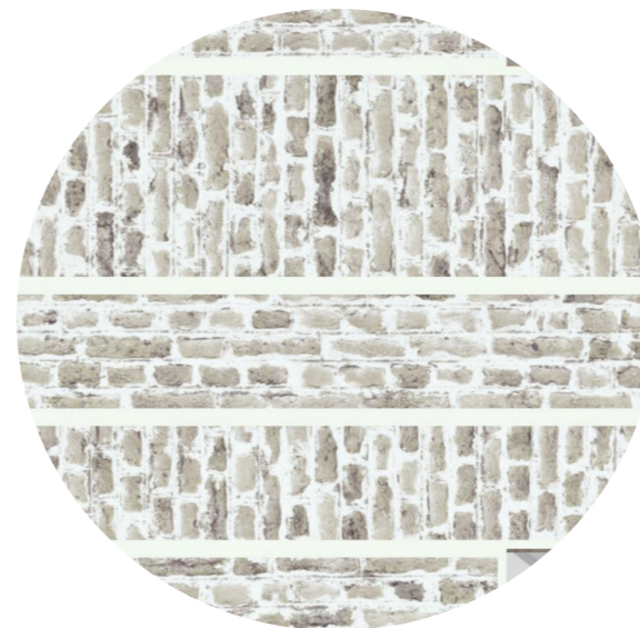
MÖNSTERMURAT TEGEL Primärt stenmaterial i Höghusets fasad.
