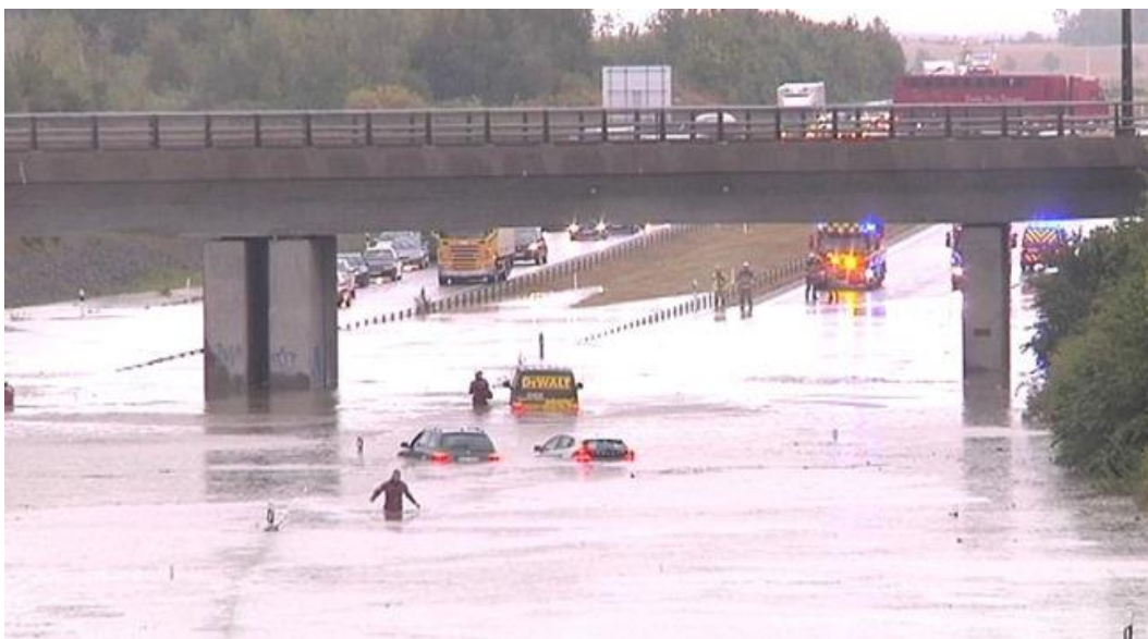
Figur 22 Översvämmad viadukt i Malmö den 31 augusti 2014. (www.svt.se)
