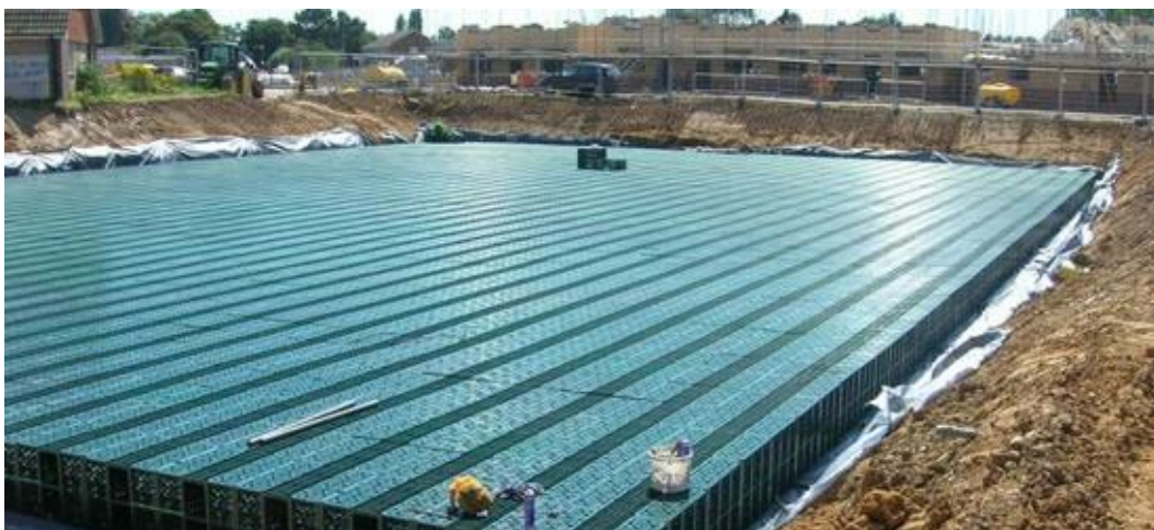
Figur 20 Anläggning av stort fördröjningsmagasin under mark. ( http://www.externalworksindex.co.uk/entry/33340/Hydro-International/Stormbloc-stormwater-storage-infiltration/ )
