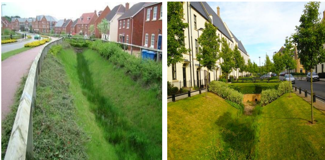
Figur 17 Diken med fördröjande sektioner integrerade i stadsmiljön med exempel från England. (www.pinterest.com)
