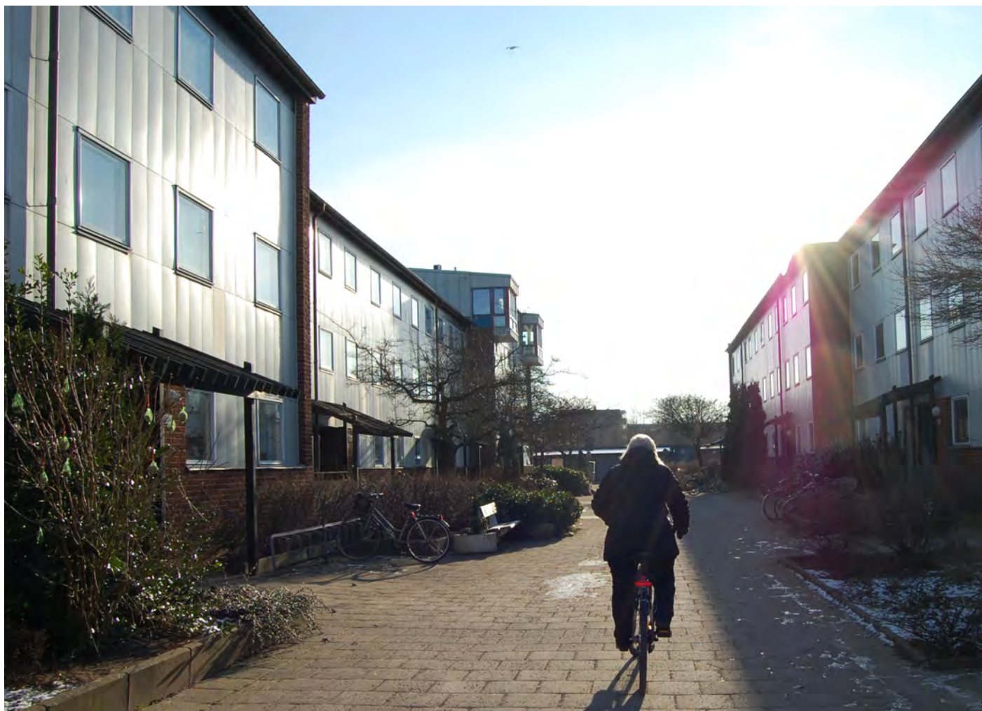
En av entrégatorna. Längst bak i bilden syns en påbyggnaderna av en fjärde våning.
