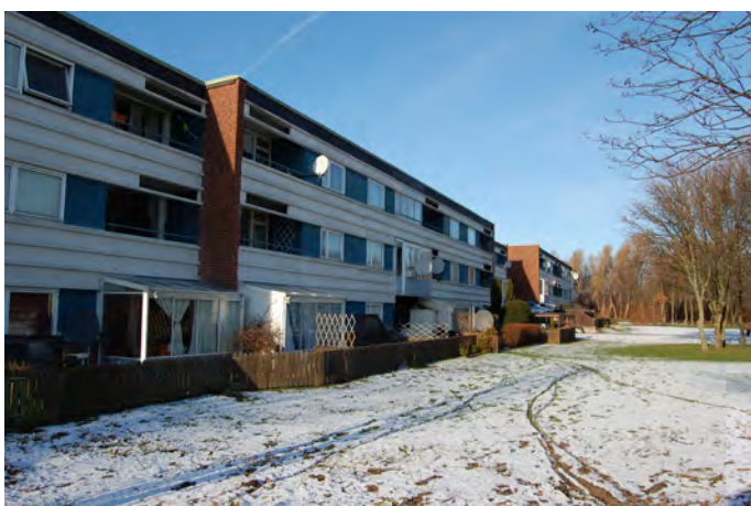
Husfasader, balkongsidan, ut mot de gröna mellanrummen.
