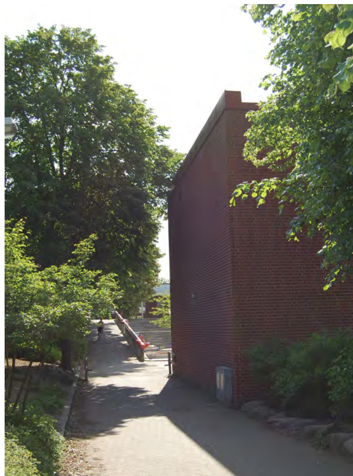
Förslag till plats för nytt Kulturhus. Med en transparent entréetage kan förbipasserande ”fångas upp” från båda sidor.
