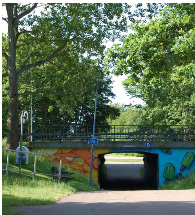
Gångtunneln under Vasatorpsvägen.
