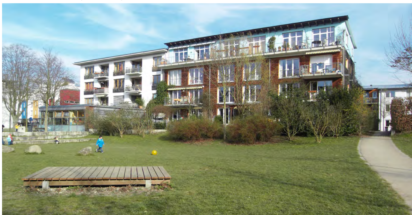
Ovan ett exempel på fyra vånings bostadshus ut mot ett grönt mellanrum, liksom de på Drottninghög. Bilden är från Freiburg, Tyskland.
