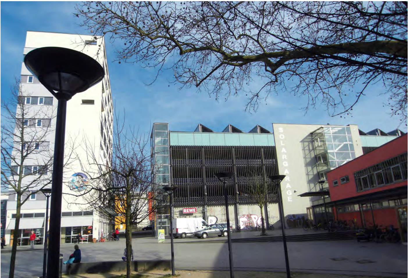
"Solargarage" är ett parkeringshus med solpaneler på taket som bl.a. alstrar energi till bilpoolens elbilar som står parkerade i garaget. Bilden är från Freiburg, Tyskland.
